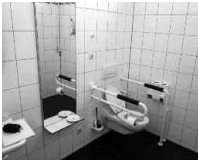
■ Bild einer Behindertentoilette, wie wir sie 1:1 übernommen haben und in der Traumatologie in Chisinau erstellen.
