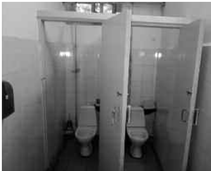
■ Bild der durch EG-Gelder erstellten und angeblich „Behindertengerechten Toiletten“ in der Traumatologie in Chisinau. Bilder: Hartig.
