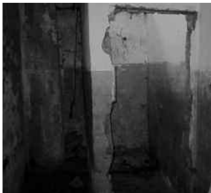
■ Die Toiletten der Psychiatrie in Edinet. Die Türen wurden verheizt. Es ist nur ein Loch im Boden vorhanden.
