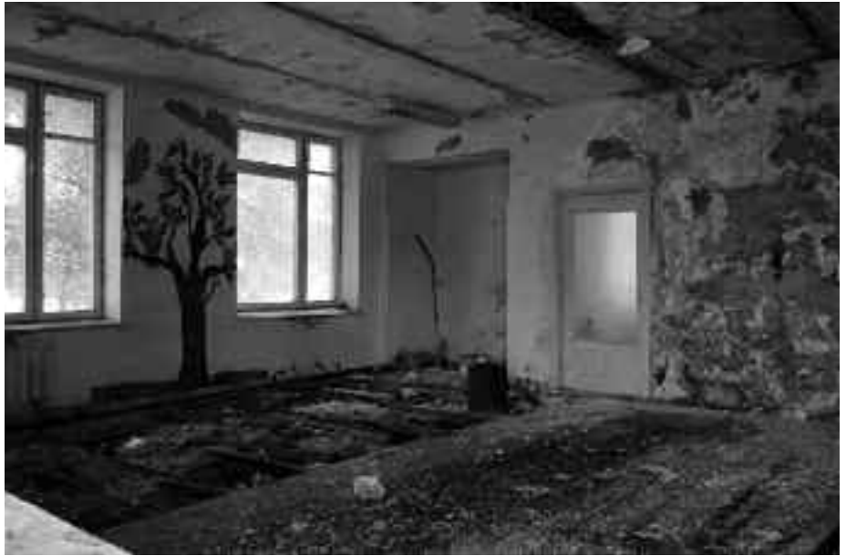
■ Kindergartenräume in Edinet. Wir waren sprachlos, was nach 20 Jahren Selbstständigkeit der Moldau immer noch vorzufinden ist.
