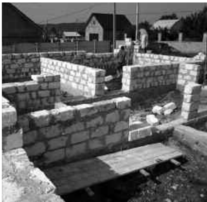
■ Fundamente sind gesetzt und der Aufbau der Wände lässt bereits die einzelne Raumaufteilung erkennen.
