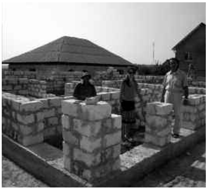
■ Bauingenieur Ion Vuico rechts, bespricht mit der Baumannschaft das weitere Vorgehen. Der Wettergott meint es gut mit uns und so schreiten die Arbeiten zügig voran. Bilder: Hartig
