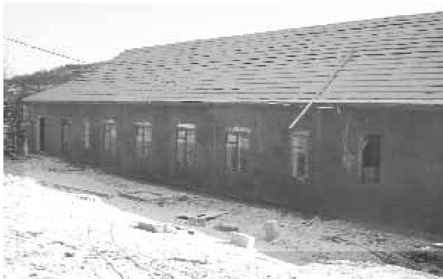
■ Kindergartenprojekt voll in Arbeit. Das Dach ist bereits mit Isolation und Dachlatten gedeckt. Schneefall stoppte die Arbeiten für wenige Tage. Anfang Dezember ist der Bau abgeschlossen.
