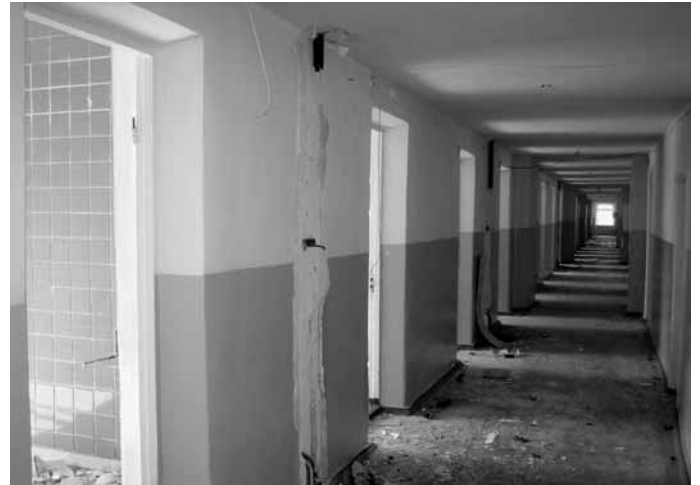
Innenflur einer Etage des Tuberkulosezentrums in Vorniceni. Der Bau wird entkernt. Bilder: Hartig
