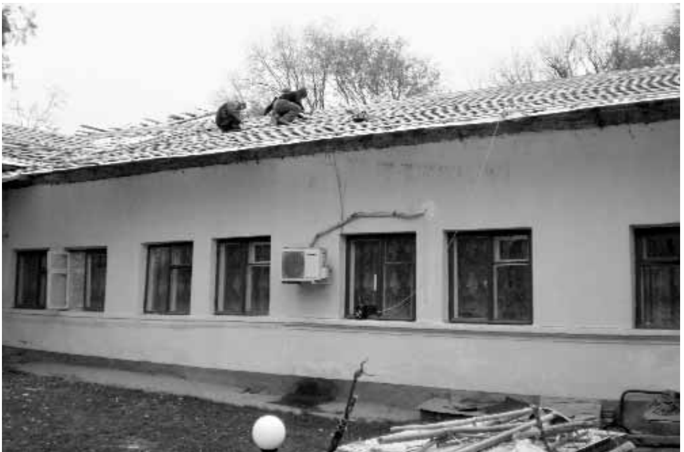
Das Altenheim in Leova. Vieles ist mittlerweile hergerichtet worden. Die Dachreparatur wurde mittlerweile erfolgreich beendet.
