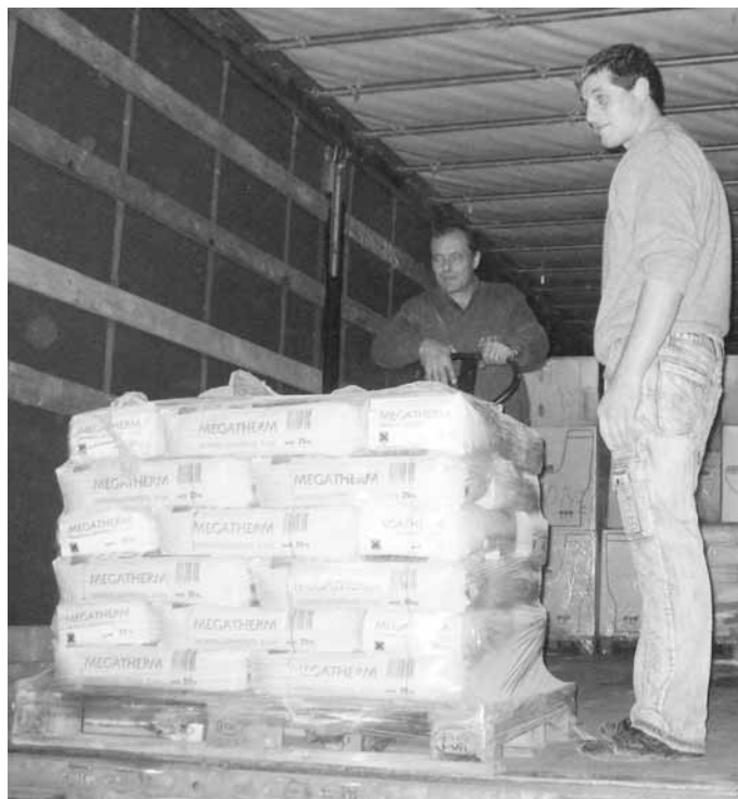
■ Entladen mehrerer Tonnen von Verputzmaterial der Firma Stotmeister in der Tuberkuloseklinik Vorniceni
