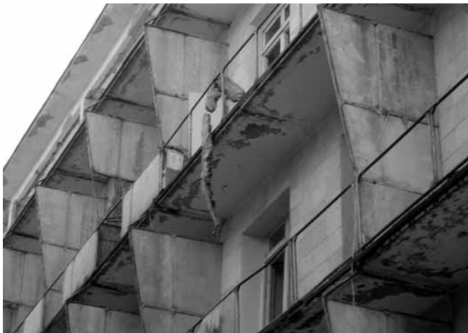
Von den Balkonen platzt großflächig der Beton ab. Das Gebäude ist nass.
