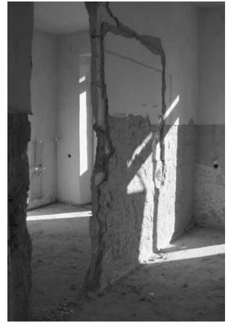
Die völlig demolierten Räume im Inneren der Klinik..
