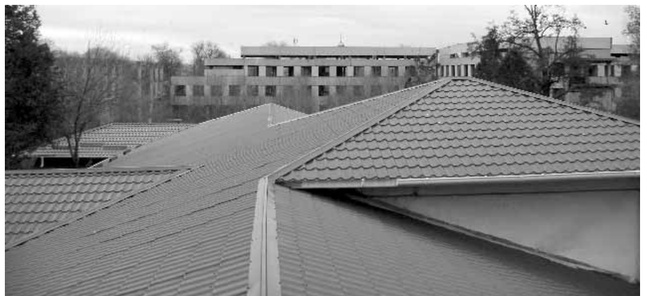
■ Ein Teil des renovierten Daches - Altenheim Leova
