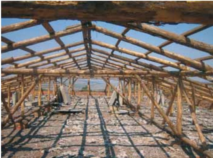
■ Der Dachstuhl der Schule in OTAC muss teilweise erneuert werden, das Dach ist neu einzudecken.
