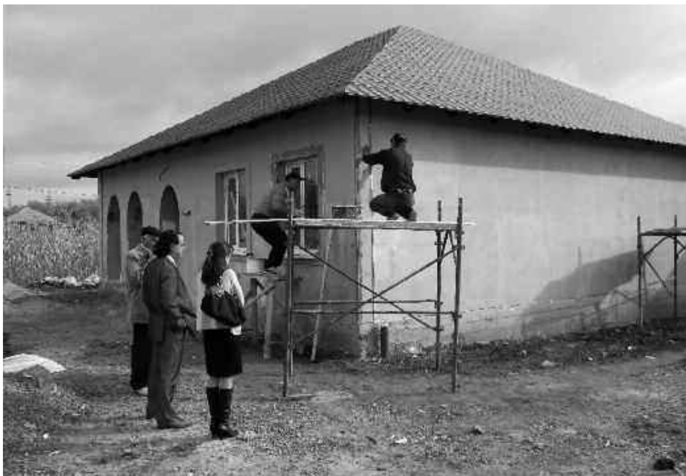
■ Es ist Ende Oktober 2011. Wir besichtigen den Titica-Bau. Die Außenisolierung wird gerade angebracht. Danach kommt der Fertigputz von STO. Die Firstbleche sowie die Regenrinne fehlen noch..
