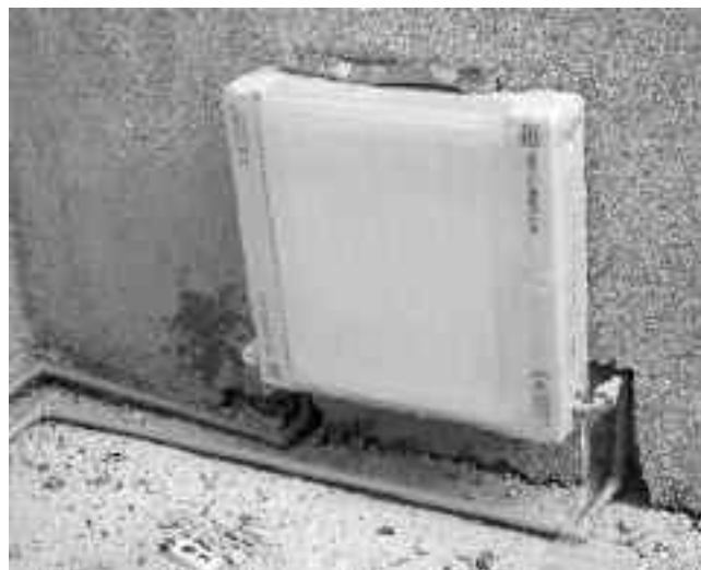
▲ Die Heizkörper und isolierten Leitungen werden montiert und unter Putz verlegt.
