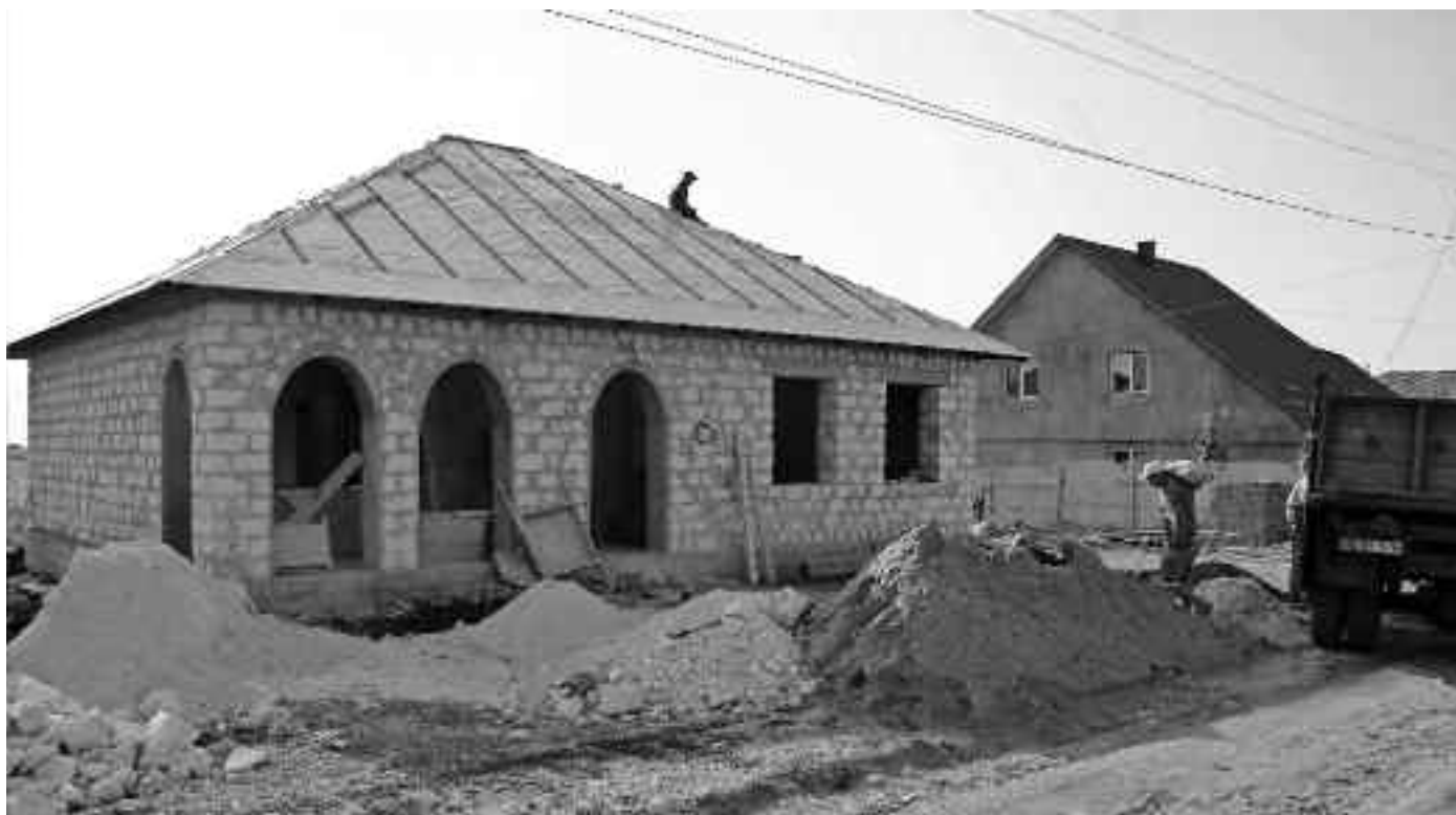
■ Rohbau des Titica-Hauses in Razeni. Dachisolation und Dachmontage werden vorgenommen.
