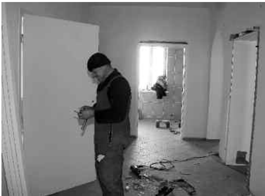
■ Die ebenfalls von der Firma EMLER in Konstanz gestifteten Innentüren werden fachgerecht eingebaut. Der Innenfertigputz der Firma STOTMEISTER ist bereits aufgebracht.
