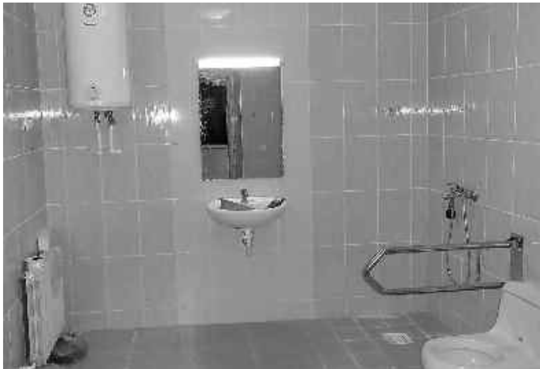
■ Der noch nicht ganz vollständige Toiletten- und Duschaum für Schwerbehinderte in der traumatologischen Klinik in Chisinau. Haltegriffe und Befestigung für die Dusche fehlen noch. Ansonsten ist der Raum in der Klinik eine räumliche „Perle“ geworden. Bild: C. Grossu
