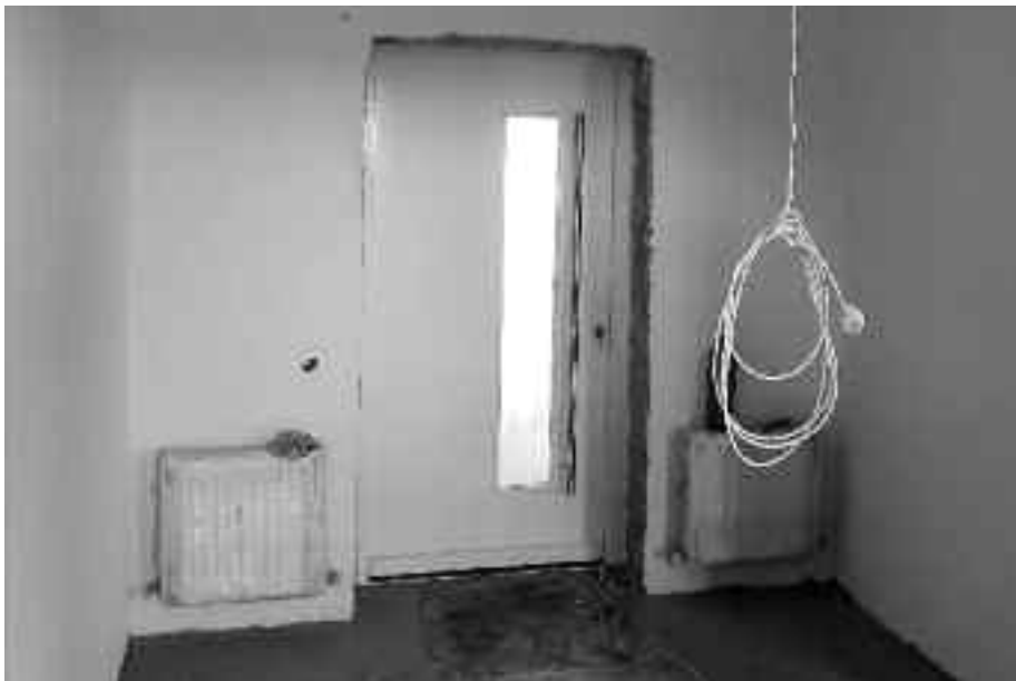
■ Einbau der sehr massiven Haustüre der Fa. Emler aus Konstanz für das Titica-Haus. Heizung und Innenputzarbeiten sind bereits erledigt. Die Elektromontage erfolgt noch.
