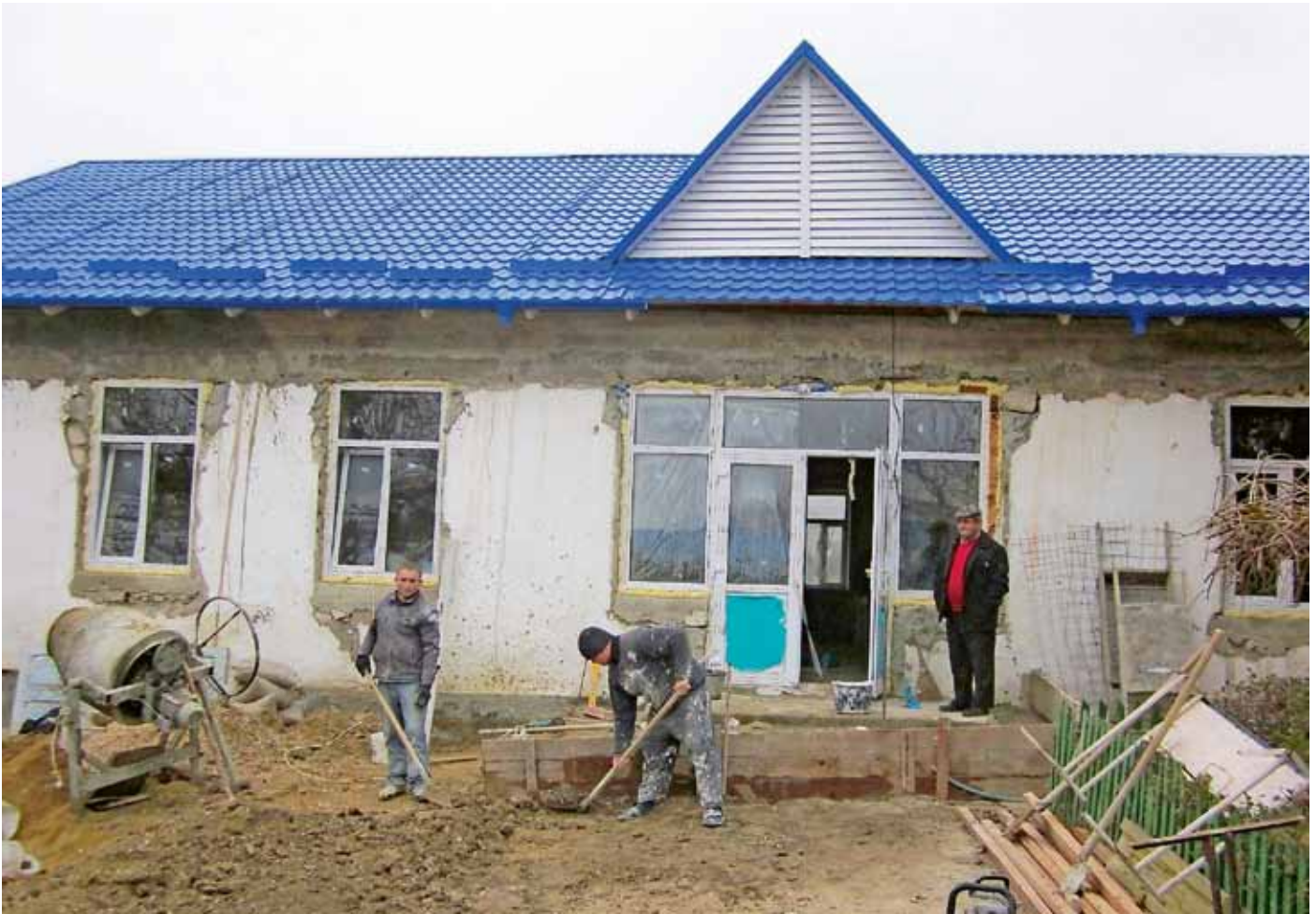
■ Mit Volldampf sind die Arbeiter noch im November 2012 dabei die Bauarbeiten zum Abschluss zu bringen.
