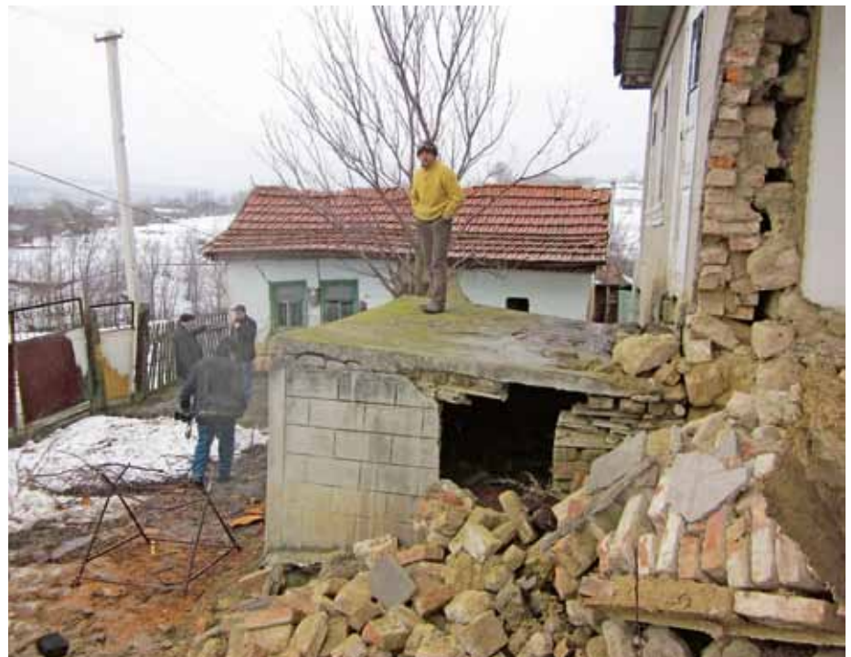
■ Die Aussenansicht verrät, dass der ganze Berghang in Bewegung ist. Alles was darauf steht, fällt in Kürze zusammen. Niemand fühlt sich verantwortlich. Ersatzunterkünfte, die bewohnbar sind, gibt es nicht. Die Erosionsschäden in Moldau finden ihre Ursache darin, dass die Republik Moldau keinen „gewachsenen Boden“ aufweist, sondern aus Sandschichten besteht.
