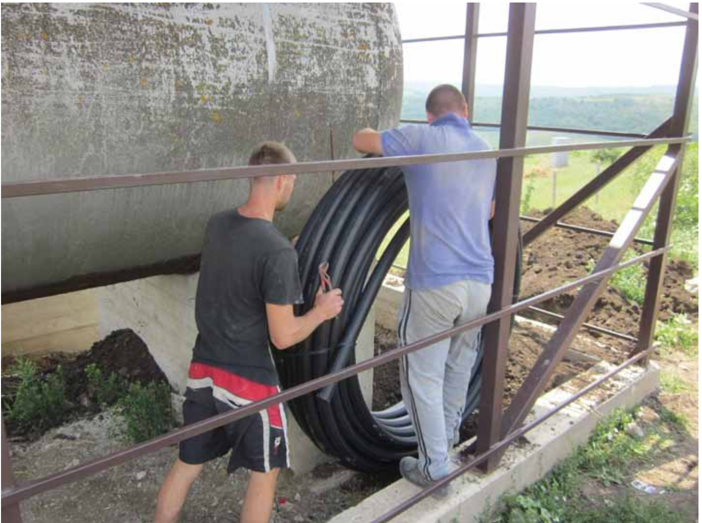
■ Verlegung der Wasserleitung vom Reservoir zum Verteiler. Das alte, bislang noch genutzte Reservoir wird abgerissen.
