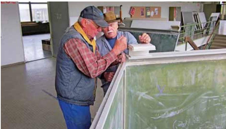
■ Unser Mitarbeiter Wilfried Kopp demontiert zusammen mit Herrn Wilhelm Bauer die sehr schweren dreiflügeligen Schultafeln.
