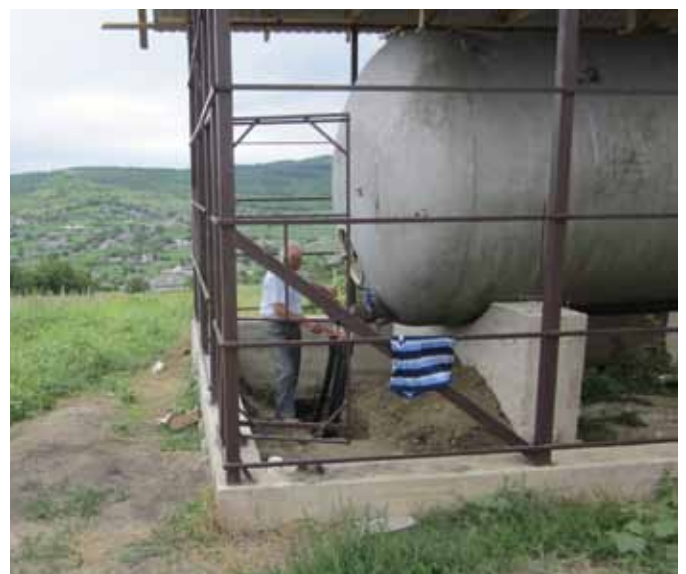
■ Unser moldauischer Mitarbeiter Ion Luchian prüft die ordnungsgemäße Wasserversorgung der Gemeinde Carbuna.
