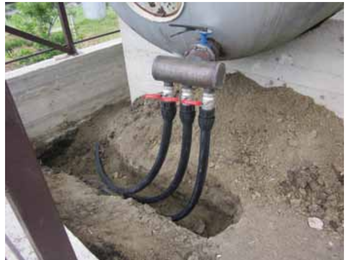
■ Die Wasserabgänge des Reservoirs sind angeschlossen.
