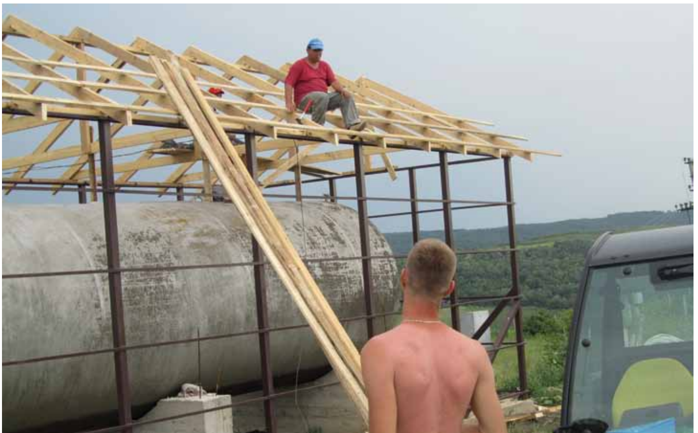
■ Im Bild oben: Die Anlieferung des Wasserreservoirs. Wir haben ein stabiles Fundament erstellt.
