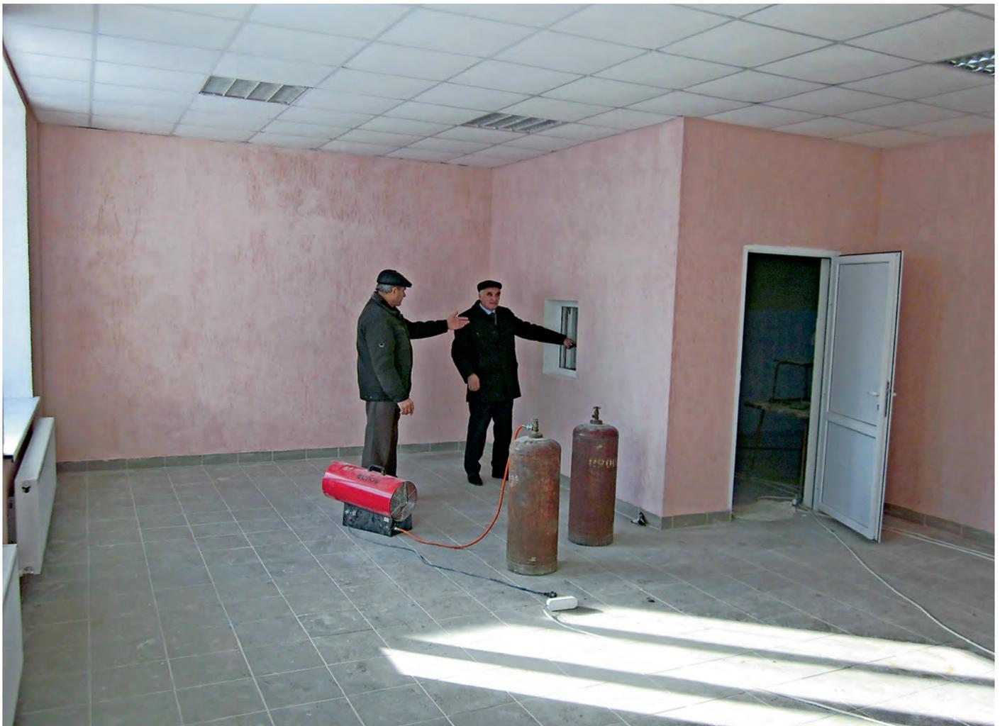
■ Der zukünftige Speisesaal mit Durchreiche zur Küche. Hier ist die Deckenbeleuchtung gut erkennbar. Die Räume werden mit einer Gasheizung zum Austrocknen beheizt. Hierbei sind die Fenster geöffnet um die Raumfeuchtigkeit zu entlüften. Bilder: Hartig
