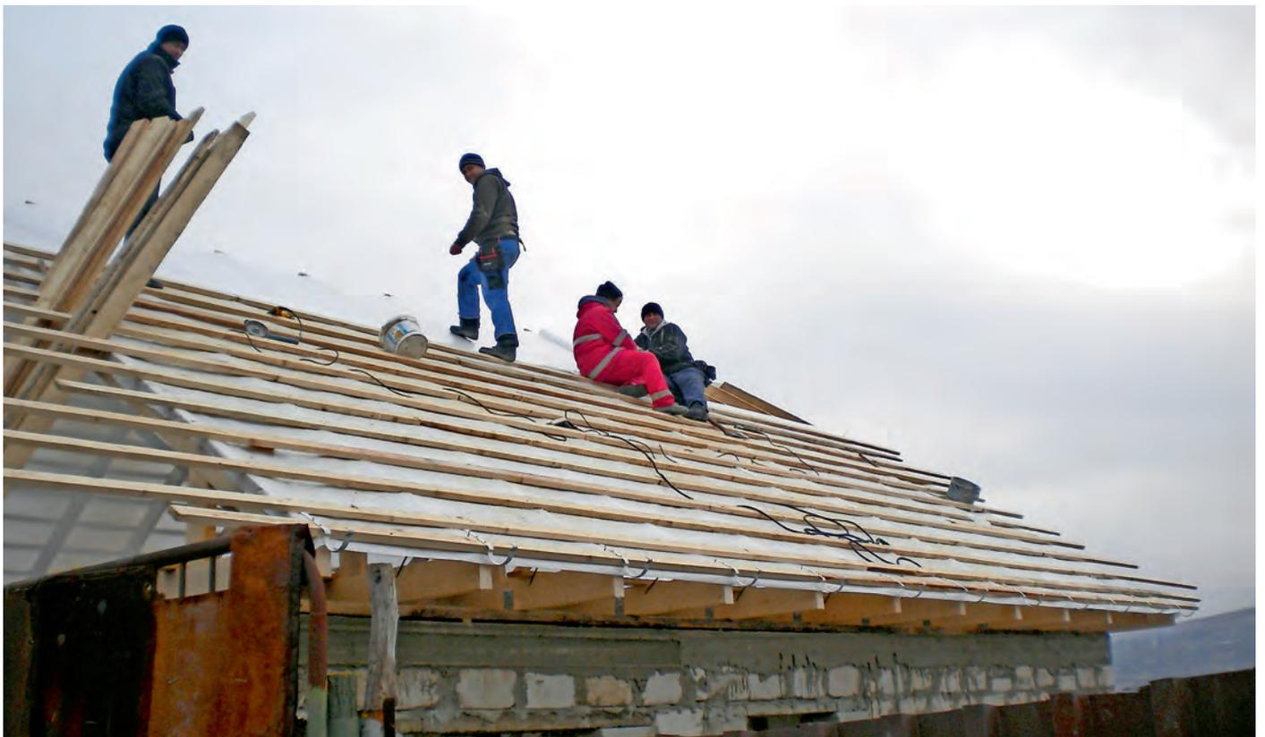
■ Die kurzfristig zusammengetrommelte Baumannschaft bei der Errichtung des Dachstuhls. Auch Isolationsfolie wurde angebracht. Der beginnende Winter in Moldau hat sich angekündigt.
