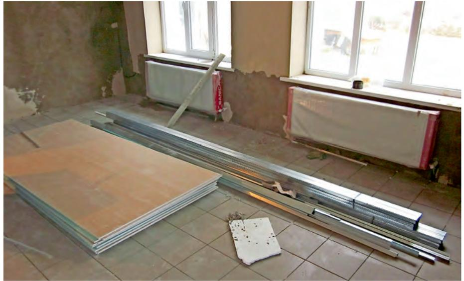
■ Rigipsplatten und Mauerschienen liegen zur Verarbeitung bereit, die Heizkörper sind bereits montiert.
