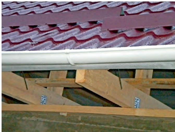
■ Das Dach ist fertig montiert und die Holzkonstruktion sauber abgebunden. Schneefangbleche und Regenrinne sind montiert.
