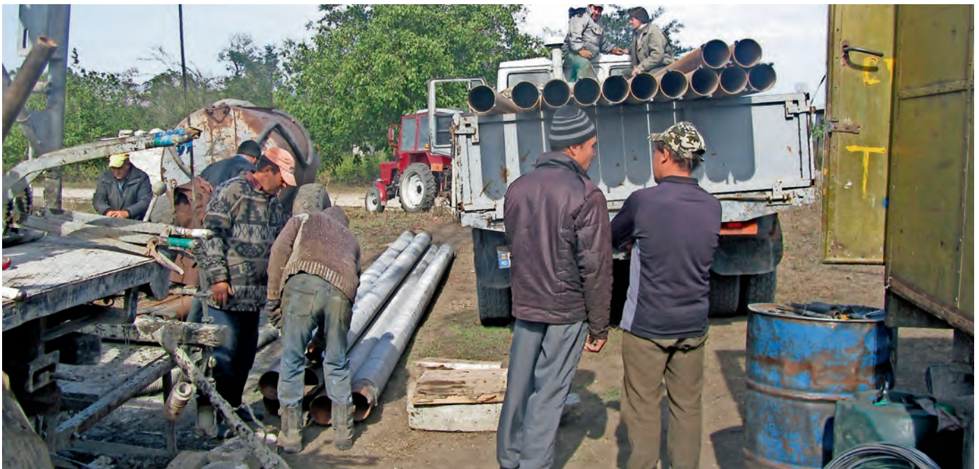
■ Die Anlieferung der Steigrohre erfolgte nach ihrem Erwerb unmittelbar per LKW aus der Hauptstadt Chisinau. Das gute Wetter lässt zügiges Arbeiten zu.
