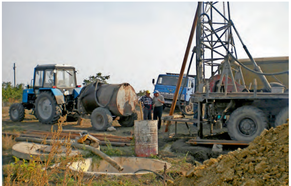
■ Die Bohrstelle wird mit der Wasserspülung eingerichtet.
