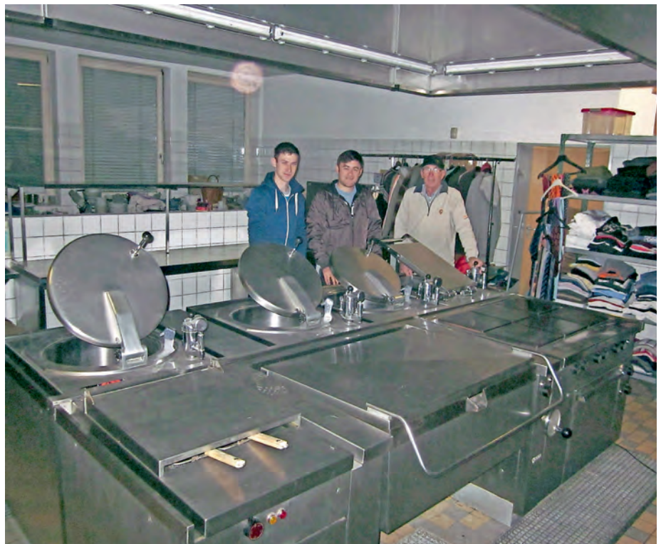
■ Die Kücheneinrichtung des ehemaligen Kinderheimes „Sonnenuhr“ in Engen vor der Demontage.
