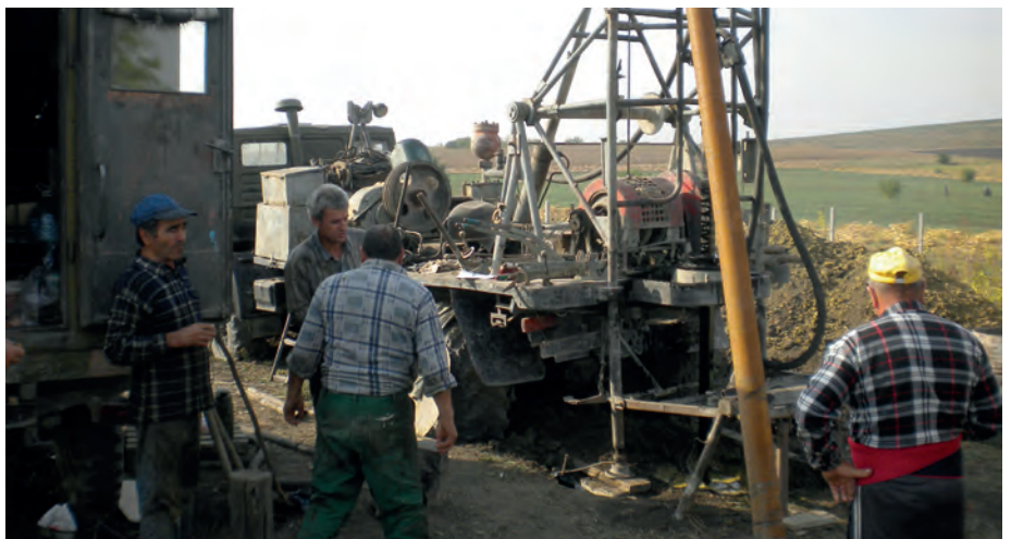
■ Unmittelbar nach Anlieferung der Steigrohre wurde mit der Bohrung begonnen.
