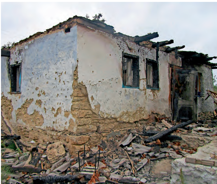
■ Das komplett demolierte Gebäude der Familie Burlacu in Lipceni.
