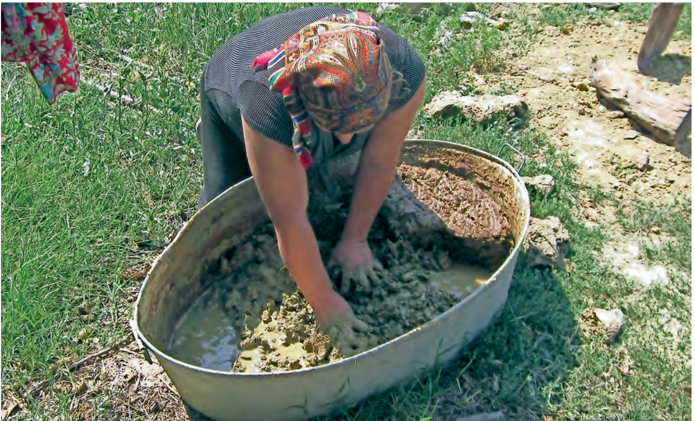
■ Frau Garbu bei der Herstellung ihres Verputzmateriales für die diversen Schäden am Haus. Die Mischung besteht aus Maisstroh, Lehm, Kuh-scheisse und Wasser. Bild: Hartig
