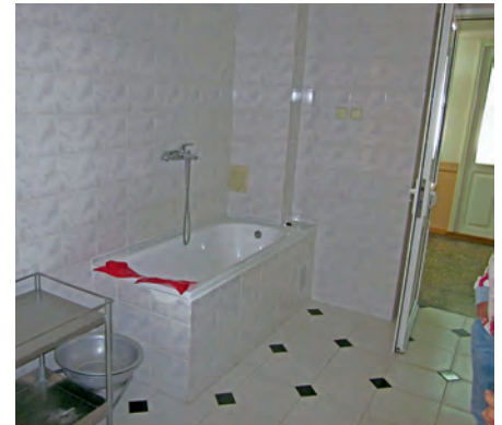
■ Klinikbadezimmer mit GROHE-Armatur
