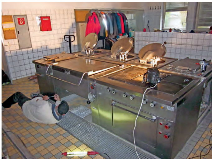
■ Beginn der Demontagearbeit.
