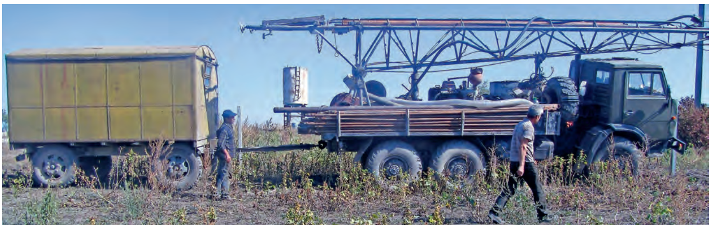
■ Anlieferung des gesamten Bohrequipments an die Baustelle in Hartop. Bild: I. Luchian
