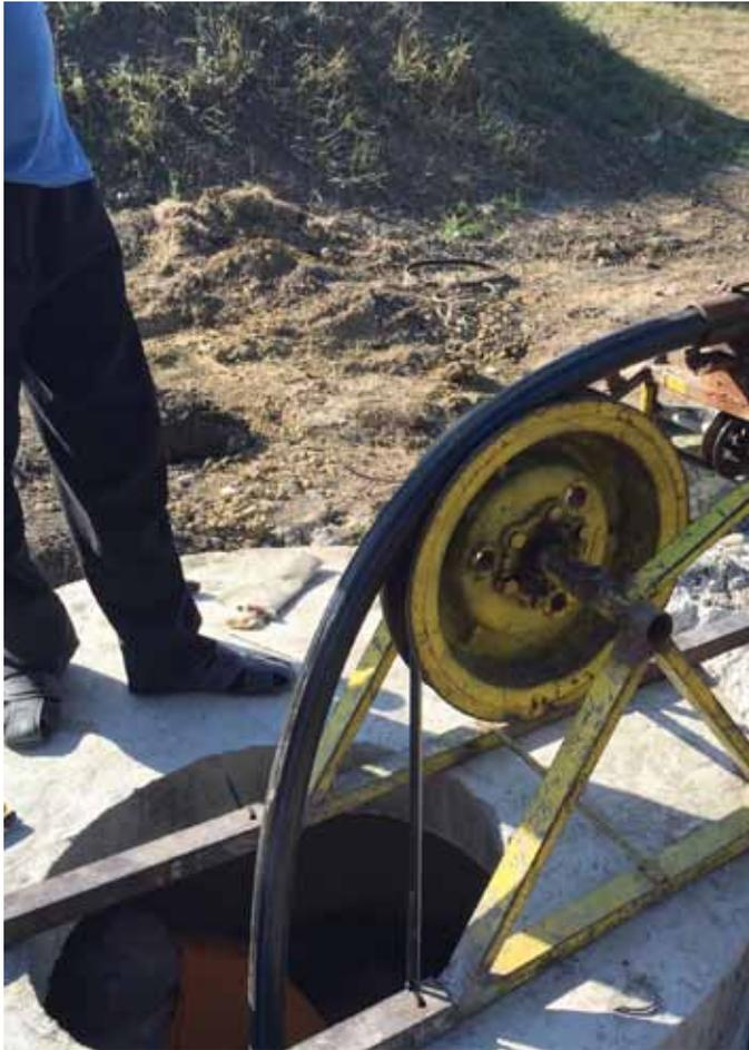
■ Die Wasserpumpe und Steigeleitung werden verlegt.
