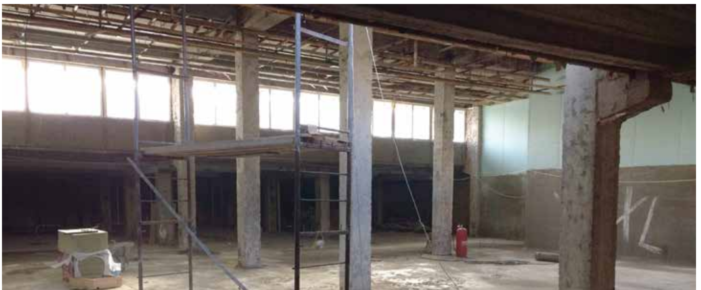
■ Der total entkernte Küchentrakt der Republikanischen Klinik in Chisinau.
