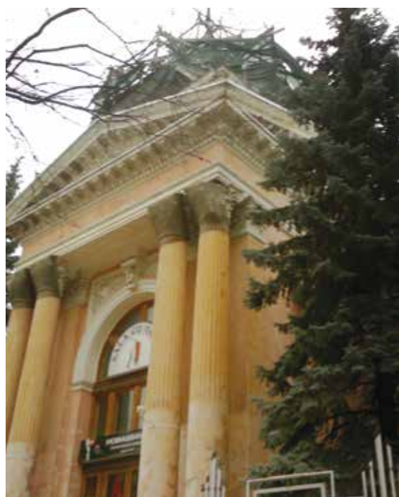
■ Orgelsaal vor der Renovation.
