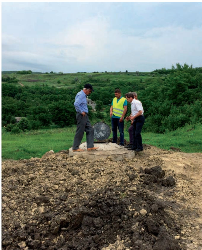
■ An dieser Stelle wurde die Tiefbohrung niedergebracht. Im Bild links unser Mitarbeiter Ion Luchian, Bildmitte ein Bauarbeiter, Bild rechts der Bürgermeister der Gemeinde Ciulucani, Andrei Ciubotaru.
