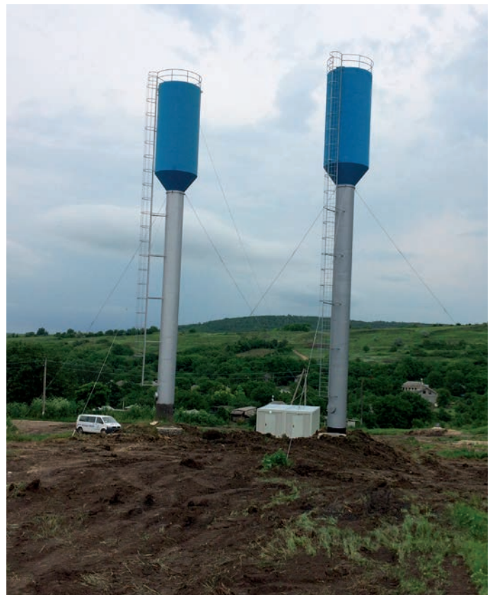
■ Die Wasservorratsbehälter und das Pumpenhaus sind bereits installiert.
