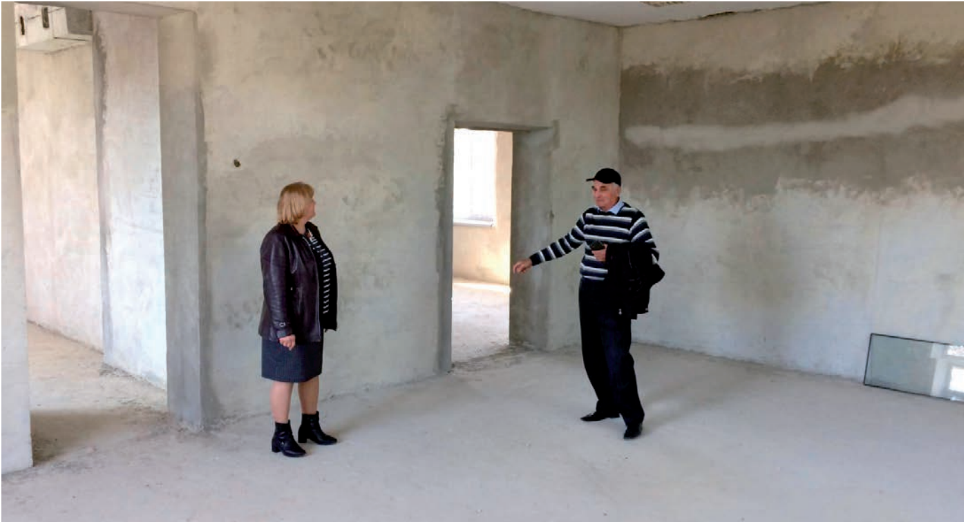
■ Im Bild links, die Bürgermeisterin von Porumbrei, Ioana Stoica, rechts unser Mitarbeiter in Moldau, Ion Luchian
