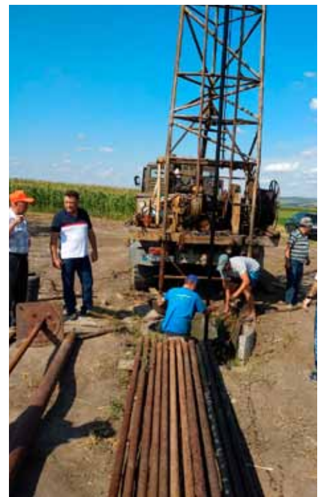
■ Bohrarbeiten im Bereich unseres Wasserprojektes in Crasnoarmeiscoe
