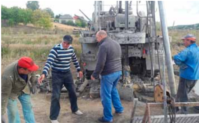
■ Die Bohrstelle wird mit dem Bohrturm und dem Bohrwagen eingerichtet.
