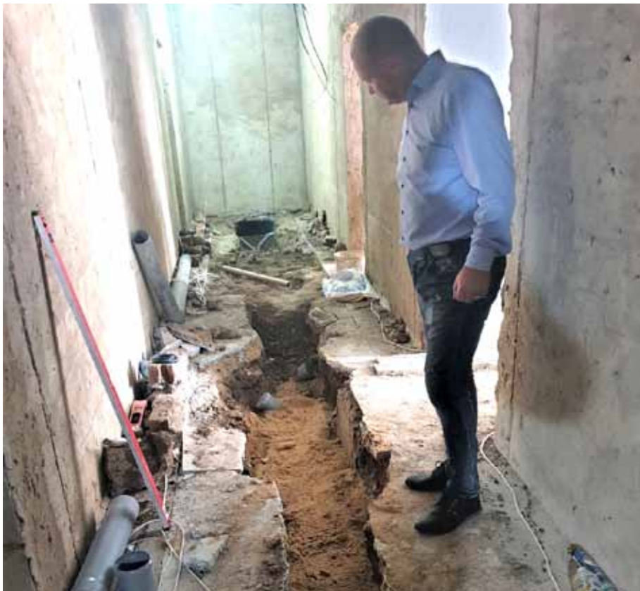
■ In diesem Bild ist erkennbar, in welchem Zustand sich die zu sanierenden Räume vor Beginn der Arbeiten befanden. Bilder: Pro Humanitate
