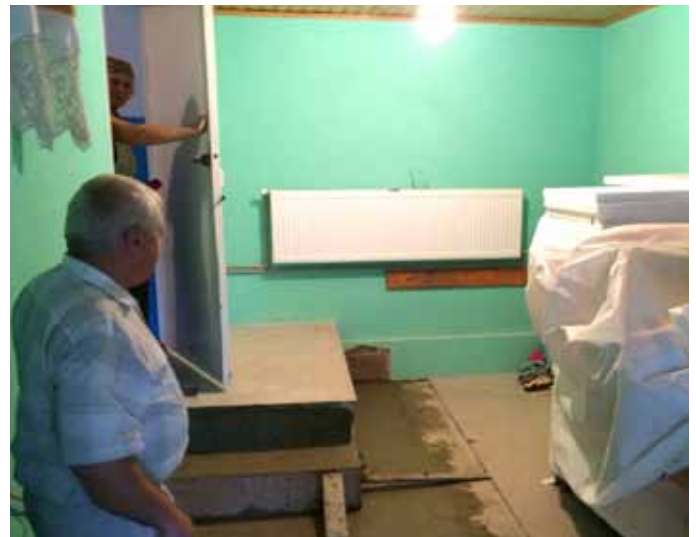
■ Man erkennt man den Heizungs radiator und die erforderliche Baumaßnahme, die mehr Platz schaffen soll.
