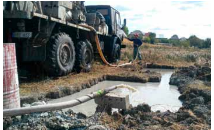
■ Der für alle Tiefbohrungen notwendige Spülteich ist eingerichtet und die Bohrarbeiten sind voll im Gange.
