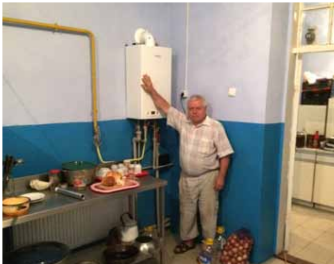
■ Die Gasheizung ist bereits installiert und funktionsfähig.
