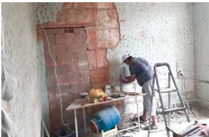
■ Die Erweiterung beinhaltet neue Plätze für die stetig steigende Anzahl der Bedürftigen.
