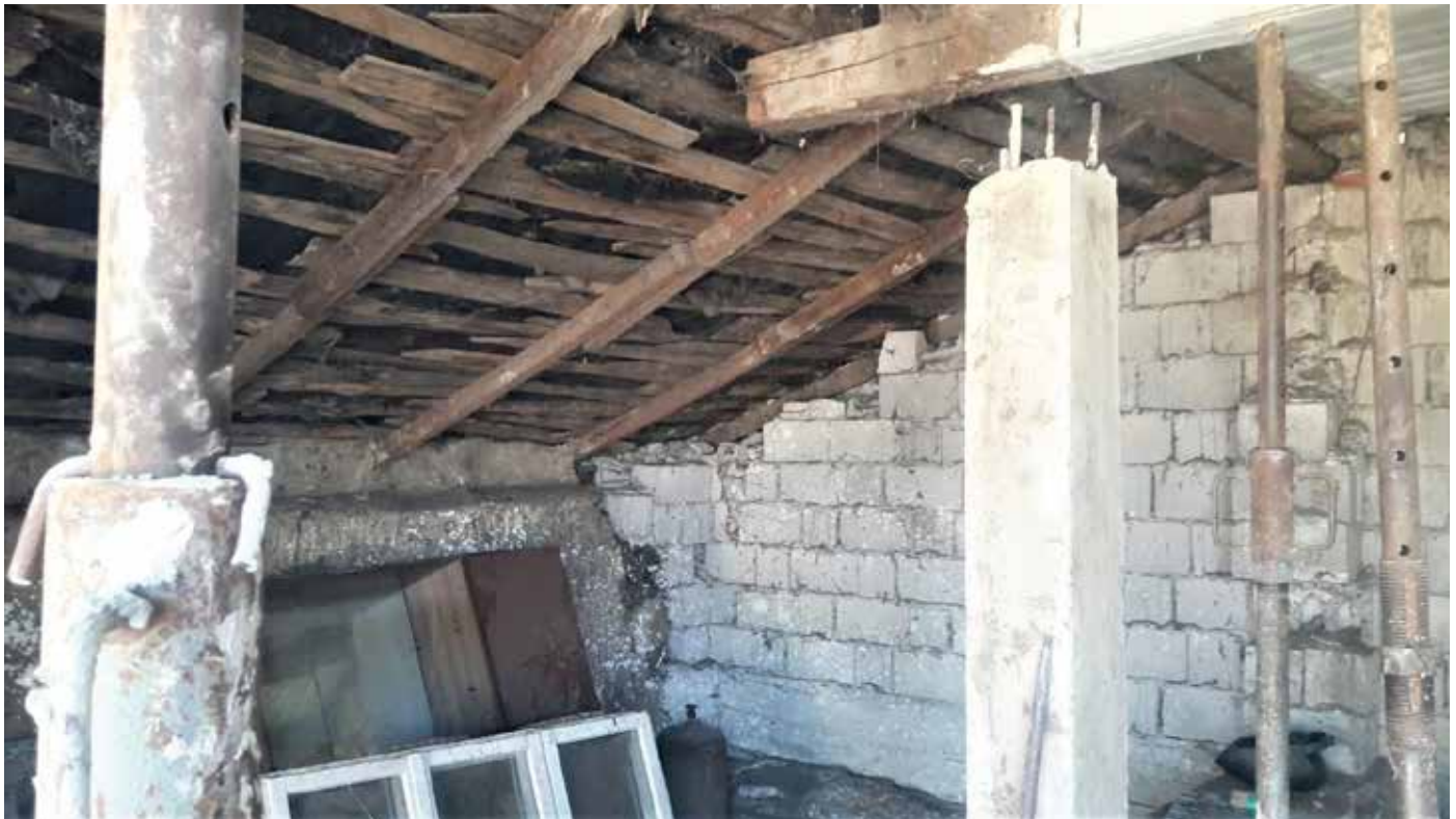
■ Dank der Patenschaftshilfe gelang es uns das vom Zerfall betroffene Anwesen der Familie Scromnaia in Tipala, wieder in einen bewohnbaren Zustand zu verbringen (siehe Bild oben und links unten).
