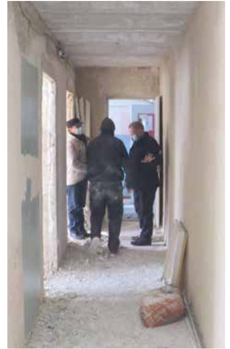
■ Rohbauarbeiten im Flur der Berufsschule Nr.2. Der Bauingenieur bespricht mit seinen Handwerkern das weitere Vorgehen.
