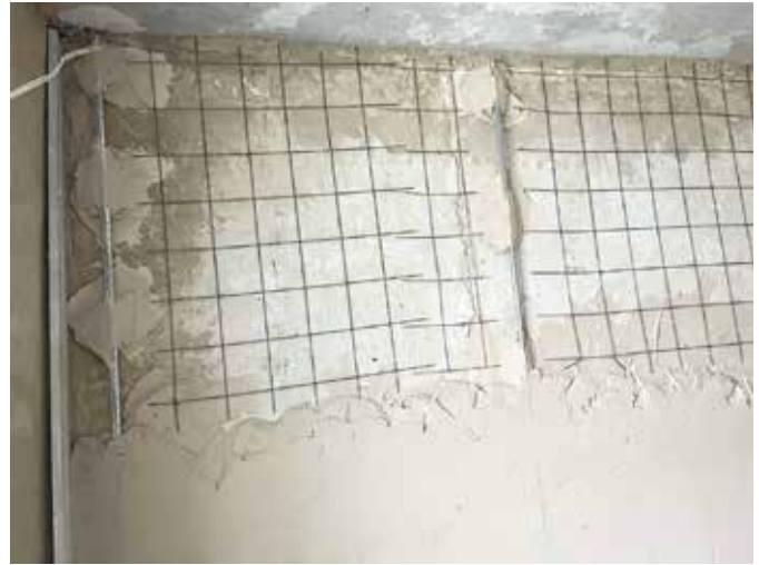
■ Teilweise müssen die Wände mit Baustahlgitter stabilisiert werden
