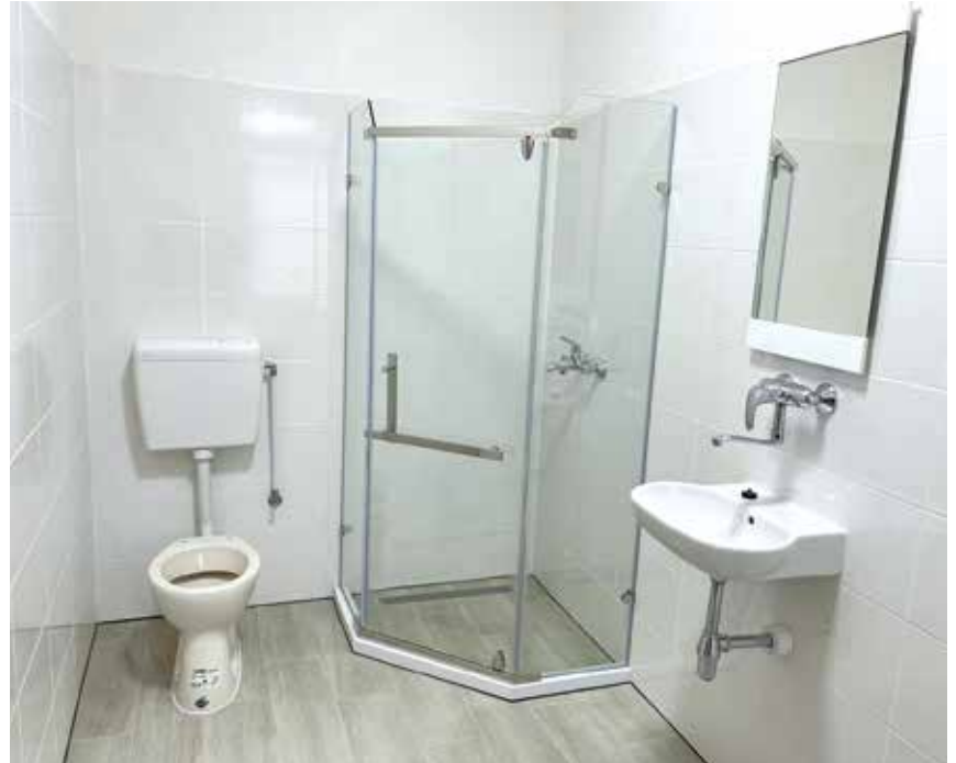
■ Eine fertig installierte Nasszelle in der Verbrennungsklinik mit Sanitärkeramik von DURAVIT und Armaturen der Firma HANSGROHE. Der Toilettendeckel wird nachgeliefert.
