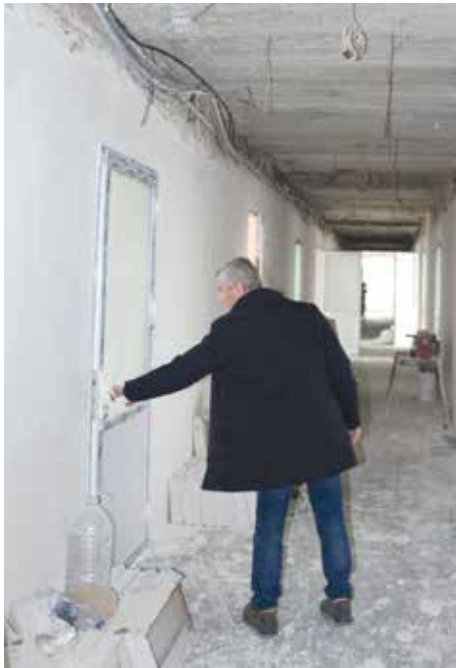
■ Dr. Tomusz überprüft Rohbauarbeiten in der Verbrennungsklinik
