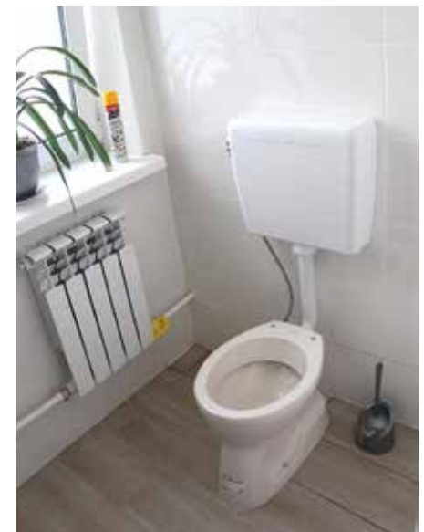
■ Fertig installierte Toilettenkabine mit Sanitärkeramik von DURAVIT, leider fehlt noch der Toilettendeckel, der nachgeliefert wird.
