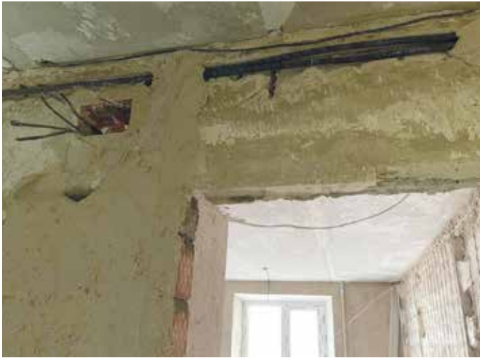
■ Renovationsarbeiten in der Berufsschule in Chisinau
