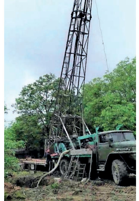
Die Bohrfirma beim Aufrichten des Bohrturms an der Baustelle in Hoginesti
