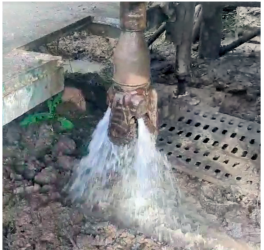
Der Bohrkopf fördert das erste Wasser aus der 170 m tiefen Bohrung.
