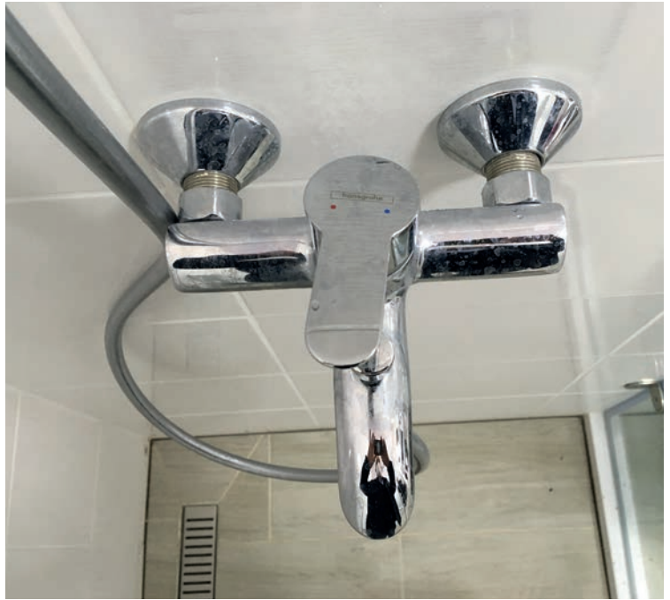
■ Die 8 Nasszellen wurden durchweg aus unseren Lagerbeständen mit gespendeten Sanitärarmaturen der Firma HANSGROHE ausgestattet.
