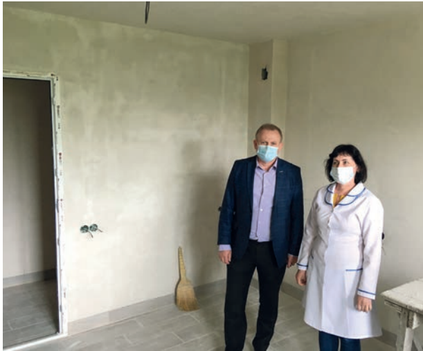
■ Der Direktor dieser Berufsschule, Vitalie Belii, mit einer Ärztin besuchen die Baustelle
