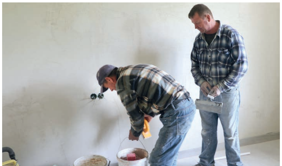
Verputzarbeiten im Erste-Hilfe Raum in der Berufsschule Nr.2 in Chisinau Bild: Pro Humanitate
