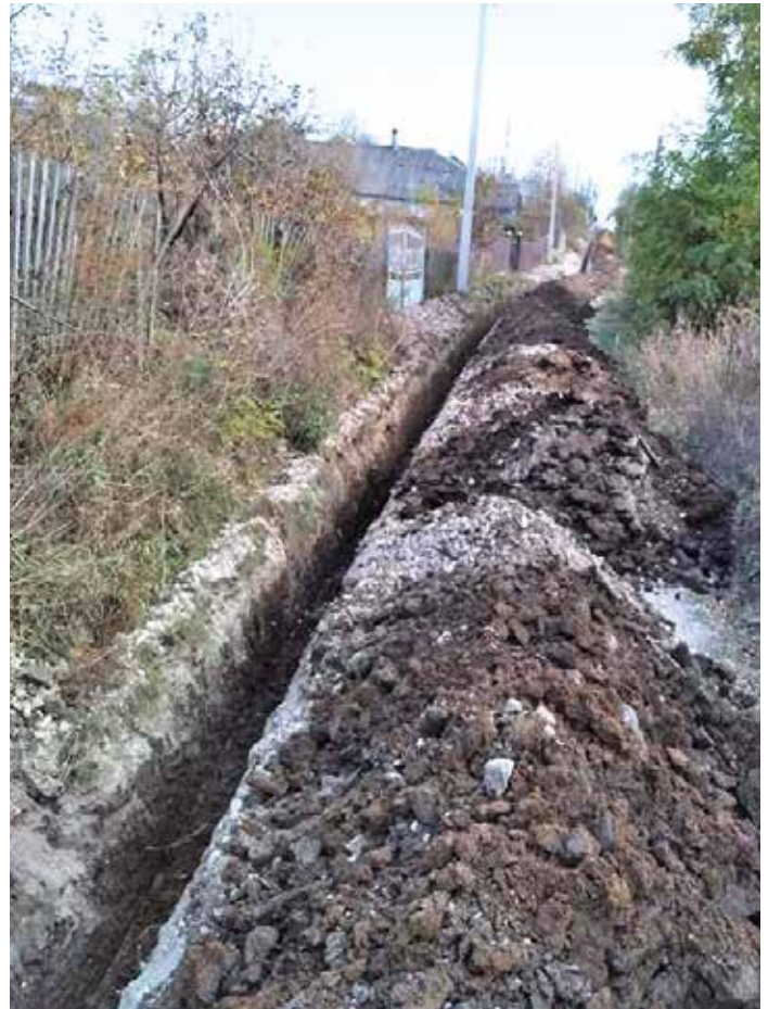
■ Ein Teil der 3000 Meter langen Wasserleitung ist bereits mit dem Bagger ausgehoben worden Bilder: Pro Humanitate
