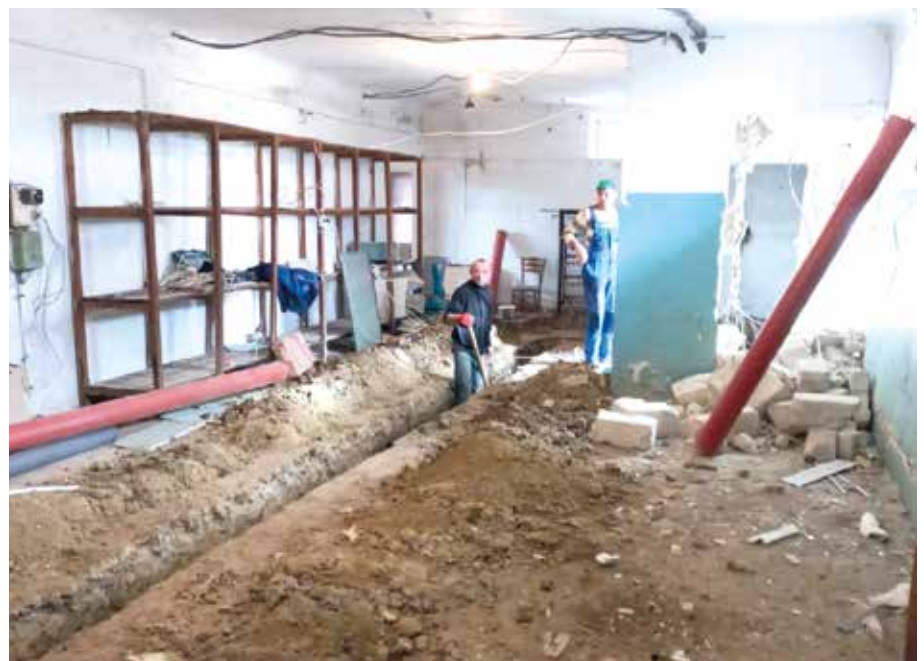
■ Der Zustand des Bauobjektes erforderte komplett neue Fenster, Türen, Fußböden sowie Wände und Decken, die gesamte Elektrifizierung sowie die Wasser- und Abwasserversorgung.
