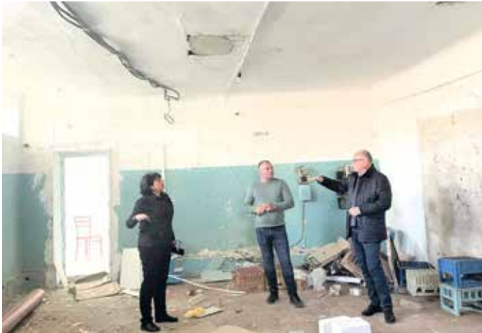
■ V.r.n.I. Finale Besprechung des Bauvorhabens – Sozialzentrum Ursoaia –, mit unserem Stellvertreter Josef Lustig, dem Bauunternehmer Constantin Lozovanu und der Bürgermeisterin Elena Marjineanu
