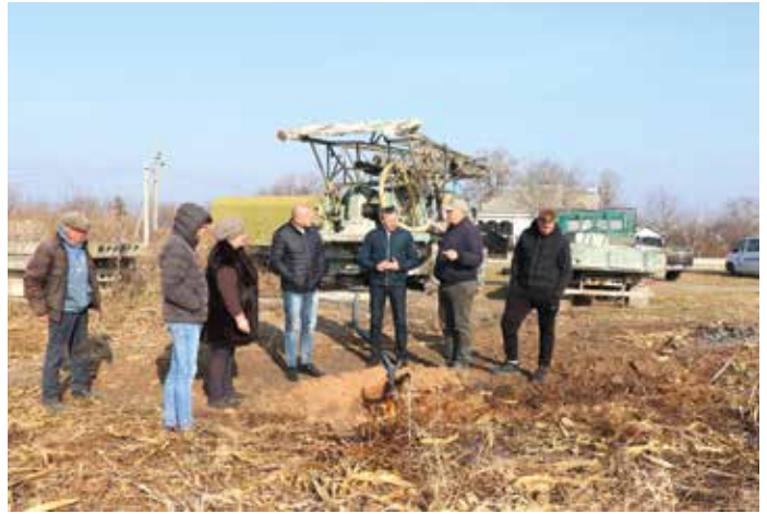
■ Die neue Bohrstelle mit der Bürgermeisterin Nadejda Negruta, unseren Mitarbeitern Sergiu Artene und Vadim Binzari sowie der Bauequipe
