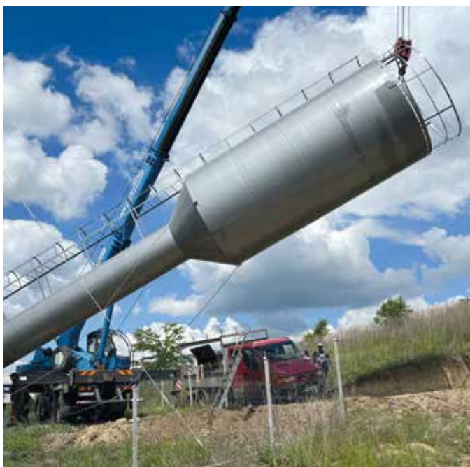
■ Mühsam und mit viel Akkuranz wird der Wasserturm aufgerichtet.
