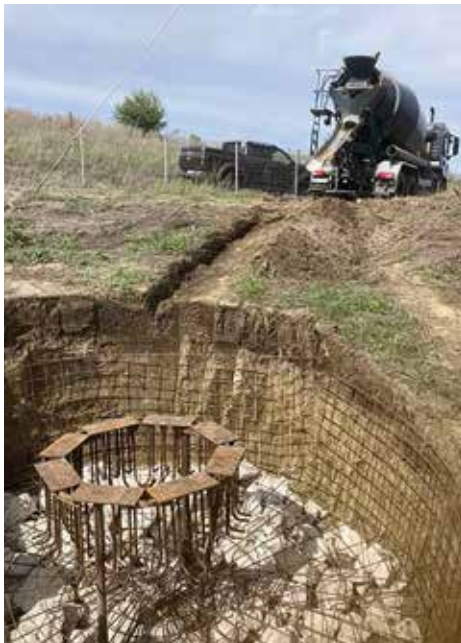
■ Schon Wochen zuvor wurde das Fundament des neuen Wasserturms bauseits vorbereitet.
