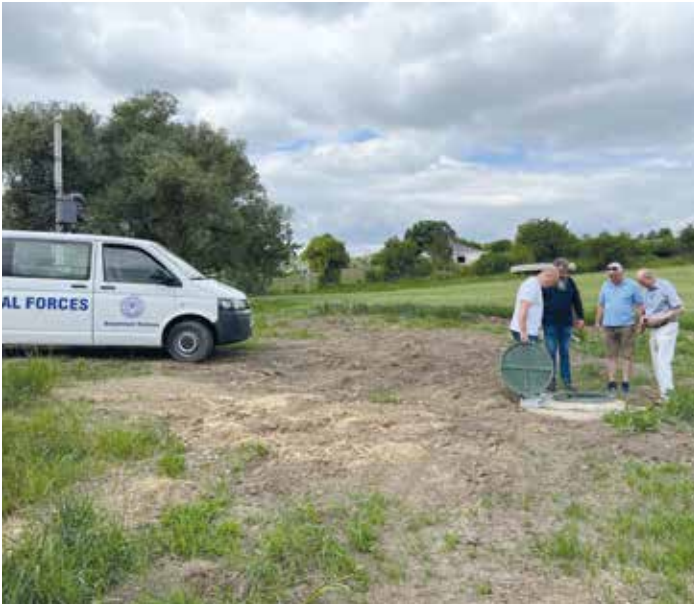
■ Wir besuchen die Bohrstelle in Dereneu. Aus Sicherheitsgründen muss diese noch vollständig umzäunt werden.
