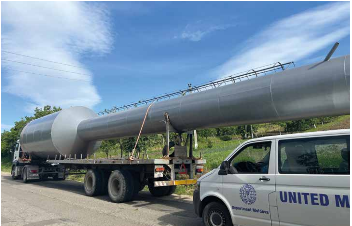
■ Wie vereinbart, stand um 7:00 Uhr der LKW mit dem „Geschoss“ in Peticeni am Straßenrand. Pünktlich konnte mit den Montagearbeiten begonnen werden. Bild: Pro Humanitate
