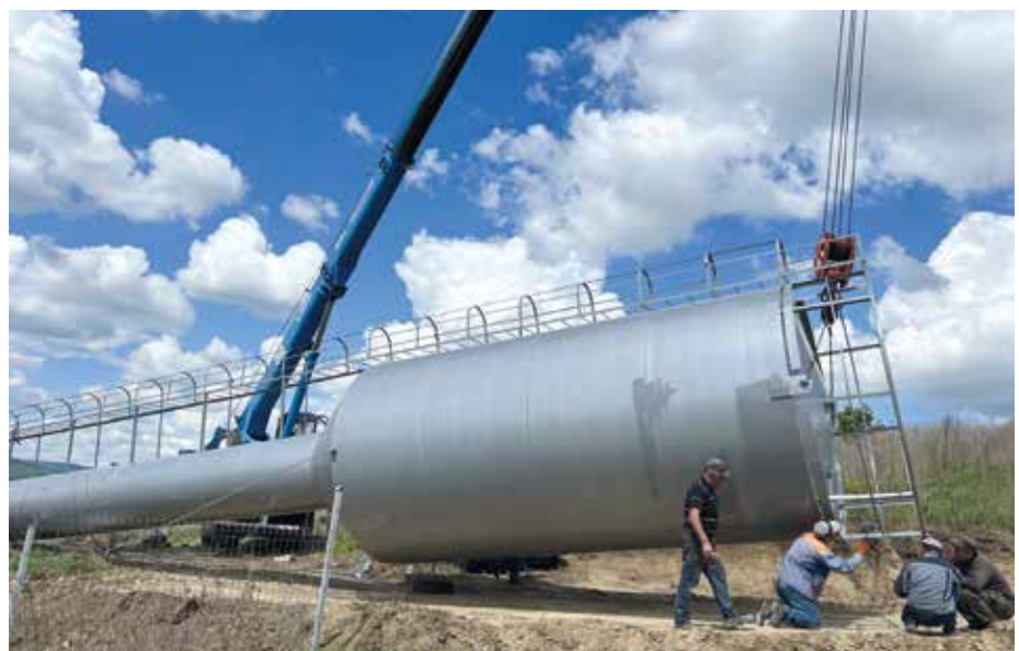
■ Der riesige Baukran hat den endgültigen Hebepunkt erreicht. Die wenigen Kratzer am Turm werden noch mit Farbe beseitigt.
