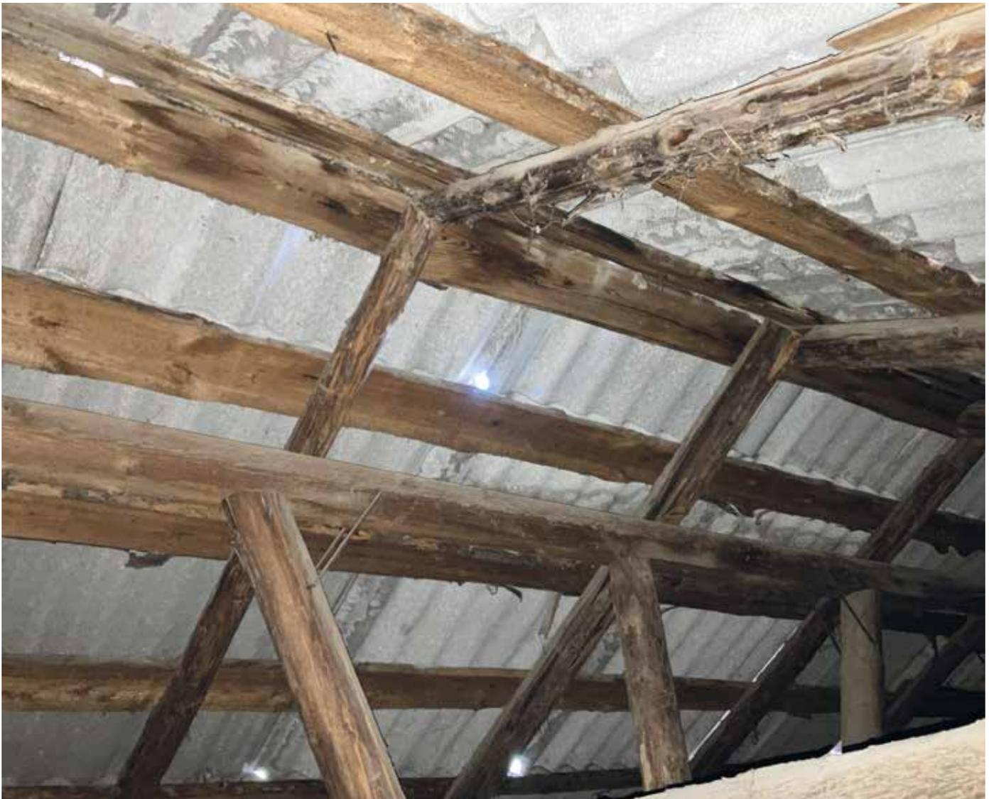
■ Das derzeitige Dach des Gymnasiums in Carbuna mit seinem völlig veralteten und durchlöchernten sowie verfaulten Dachstuhl, muß komplett erneuert werden.
