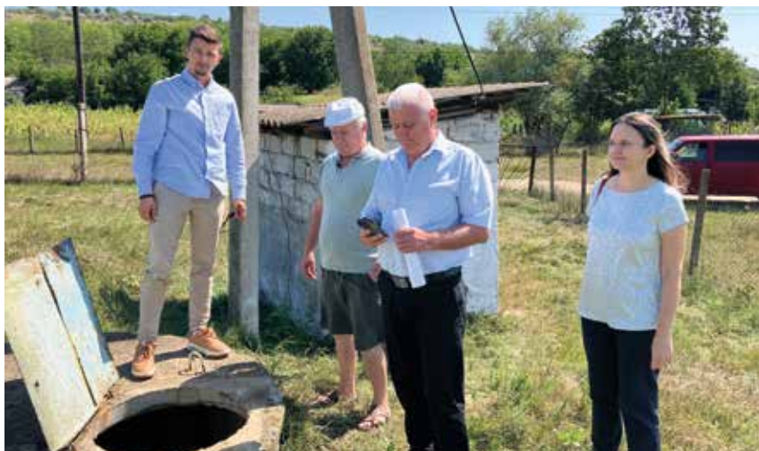
■ Besichtigung der nicht mehr funktionierenden Wasserquelle in Bahu. V.I.n.r.: Corneliu Scutaru, Vasile Focsa, Bürgermeister Pavel Bozu und Cristina Grossu.
