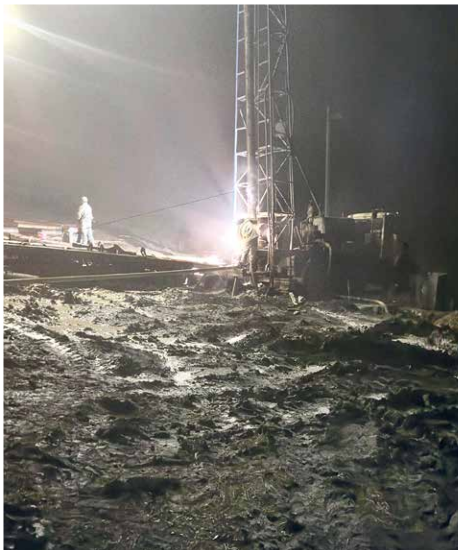
■ Die Bohrarbeiten mussten aus Zeitmangel auch nachts durchgeführt werden.
