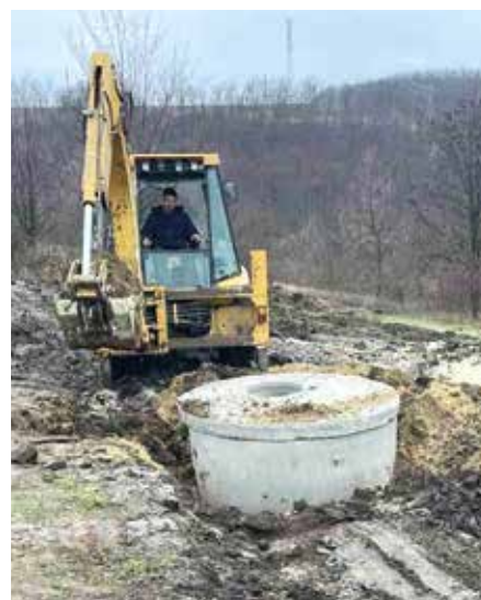
■ Die Abschlussarbeiten sind im Gange.
