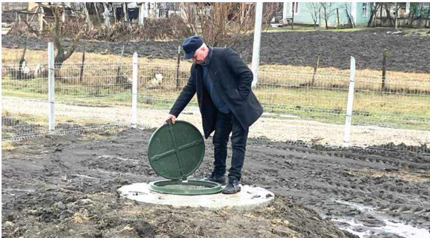
■ Der Bürgermeister Pavel Bozu empfängt uns unmittelbar an der Baustelle.
