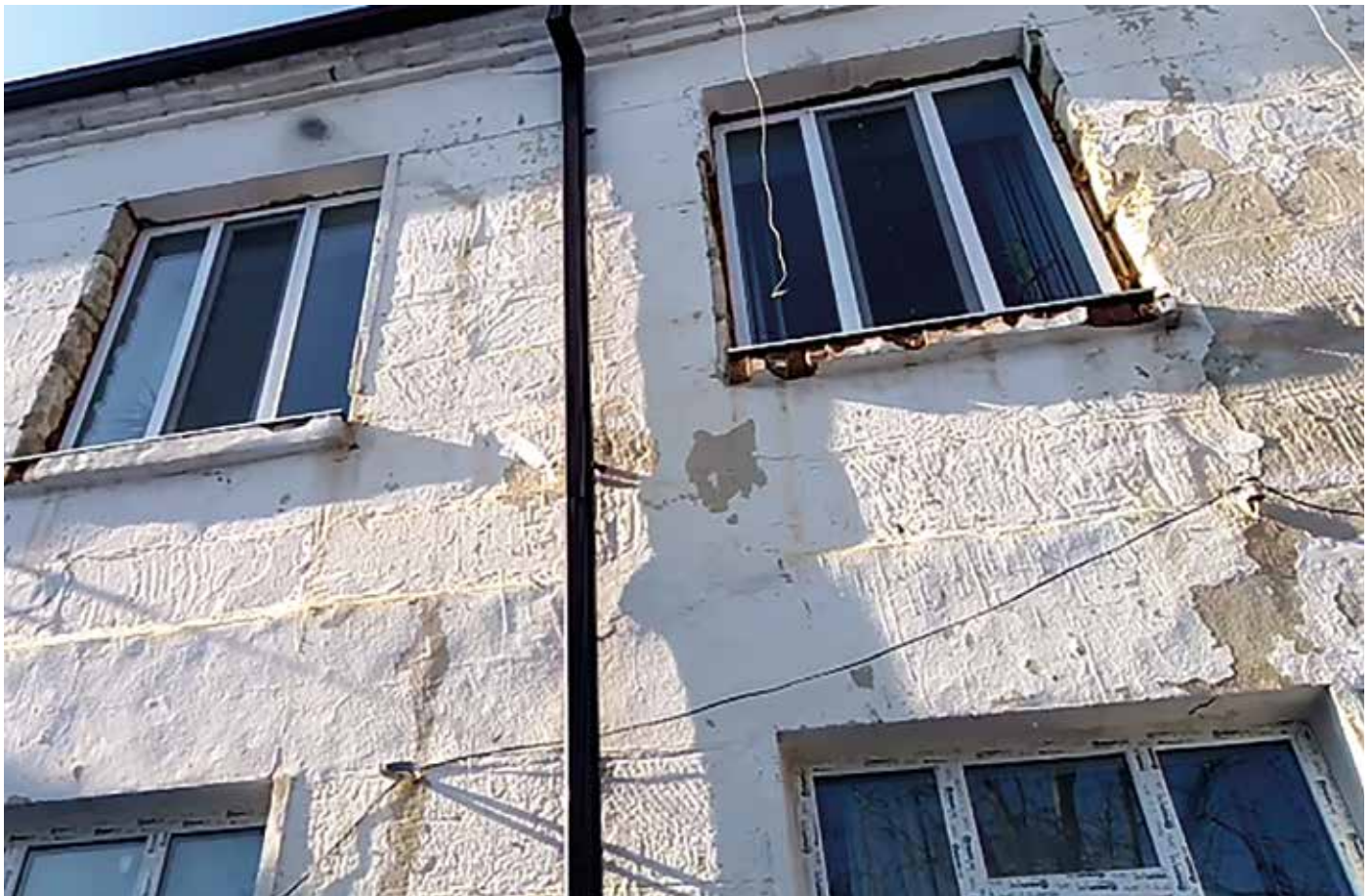
■ Bei unserem Besuch am 16.02.2026 fiel auf, dass im gesamten Gebäudebereich bereits neue Fenster eingebaut worden waren (siehe Bericht).
