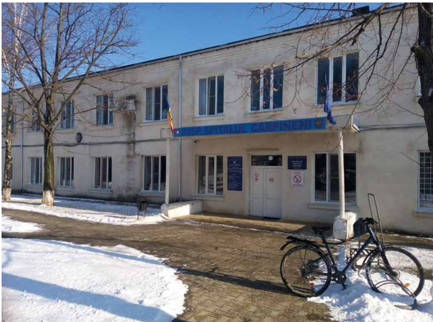
■ Haupteingang des IMSP Spitalul in Carpineni.
