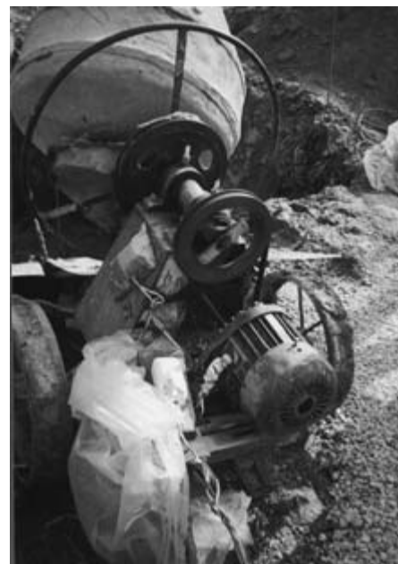
Der Betonmischer mit seiner abenteuerlichen Stromzuleitung. Bild Hartig
