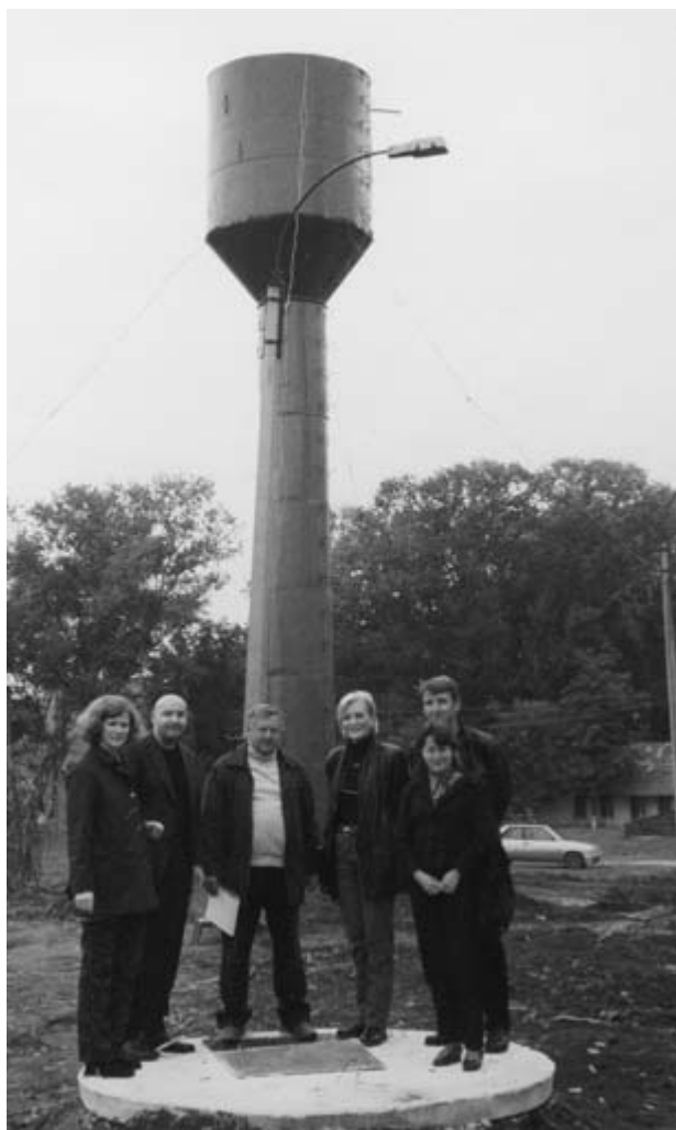
Der fertige Hochbehälter mit dem Pumpenschacht und der darunter liegenden 4. Tiefbohrung mit 121 m, die endlich sauberes Wasser bringt. v.l.n.r. Marina, Herr Guillermo Arias, unser moldauischer Bauingenieur Ivan Mihailowitsch Stefanaru, Frau Dr. Sonja Buholzer, Markus Hänggi (amtierender Präsident des Rotary Club Zürich-Turicum), sowie Frau Therese Gerber anlässlich der Projektabschlussfeier
