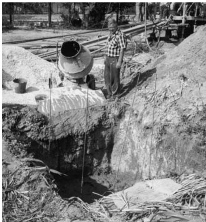
Fundament für den Hochwasserbehälter. Bild Hartig
