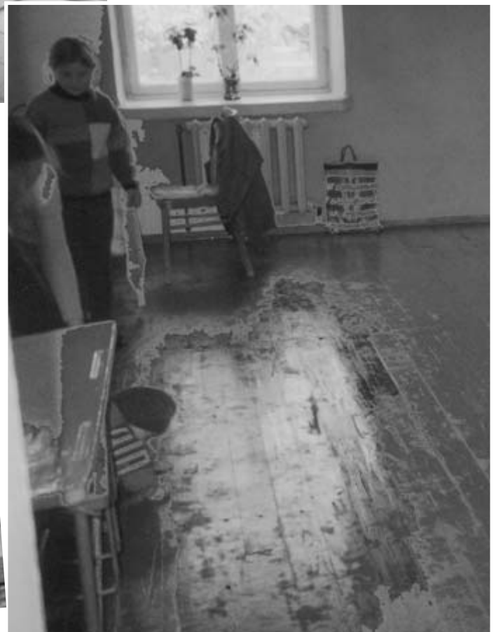
Neu eingebauter Holzfußboden nach dem ersten Anstrich. (Projektteil Schweiz)
