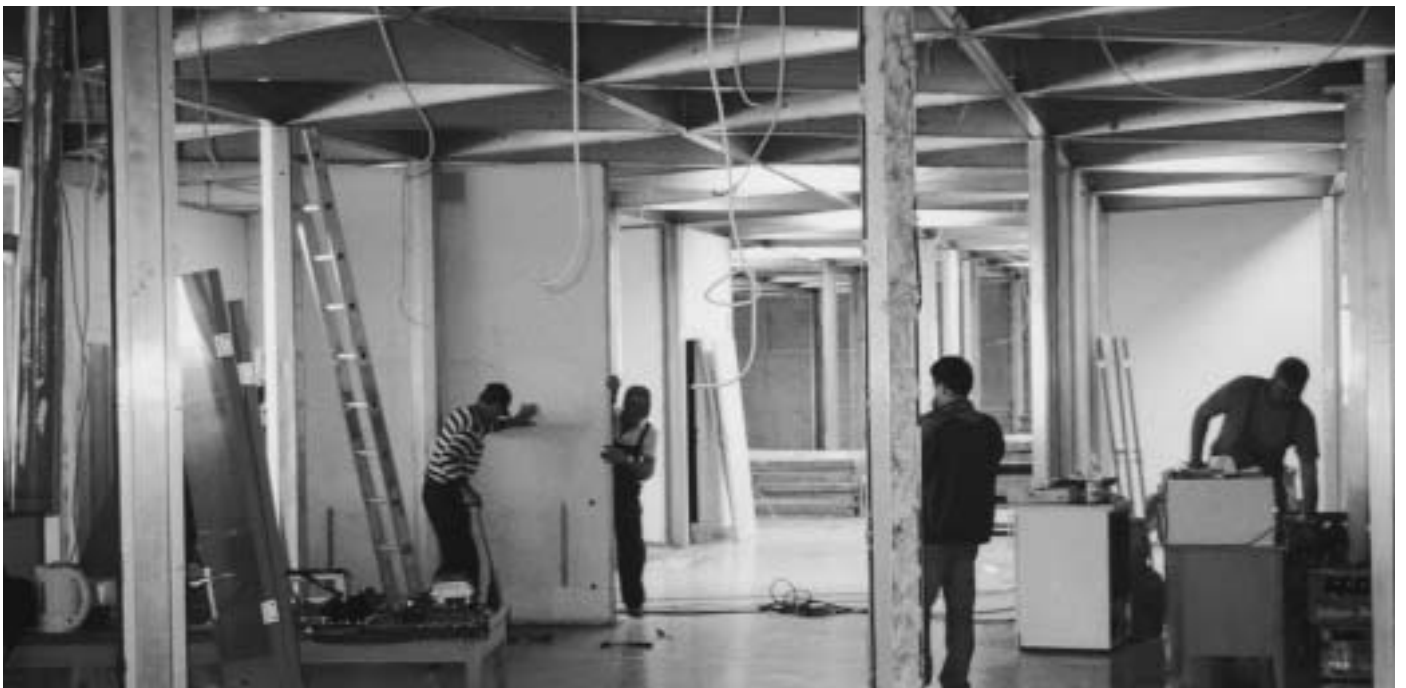
Die Innenräume werden lichter. Allerdings steht noch sehr viel Arbeit bevor. Die nicht so lärmufwändigen Arbeiten wurden im Innenbereich am Sonntag erledigt.
