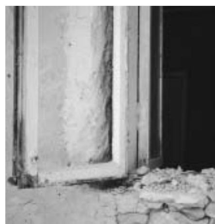
↑ Marodes Fenster und Mauerwerk
