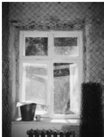
Fenstereinbau und Beginn der Innenputzgrundarbeiten
