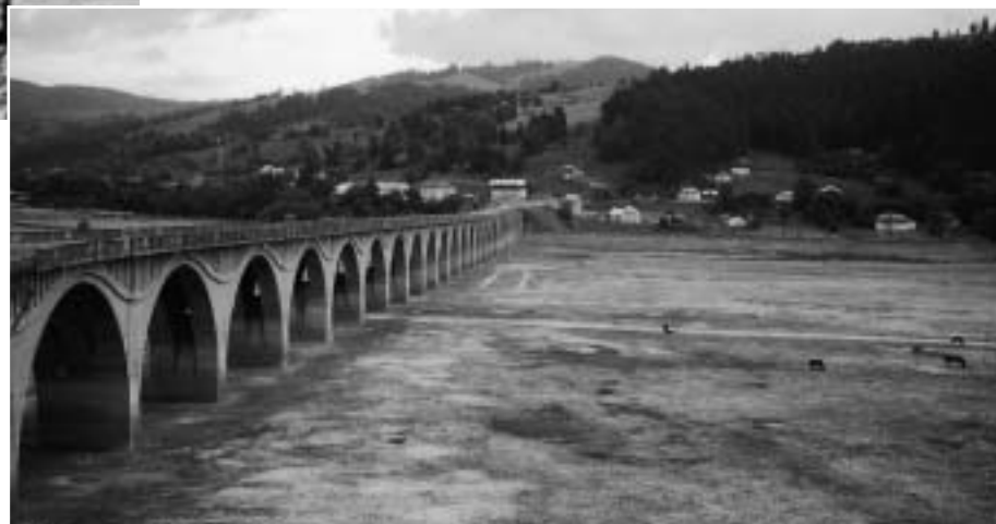
Das Wasser des Stausees wurde weitgehend abgelassen, um die Bauarbeiten zu ermöglichen. Das Viadukt bei Poiana Largului steht im Trockenen.
