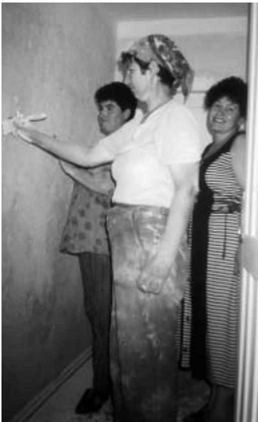
Für die feineren Verputzarbeiten werden in der Regel nur Frauen eingesetzt. Es erstaunt mich immer wieder, mit welcher Handfertigkeit gerade Frauen die Verputzarbeiten vornehmen. Wenn man eine Latte setzt, ist es nicht möglich, einen Geldschein zwischen Wand und Messlatte durchzuschieben.
