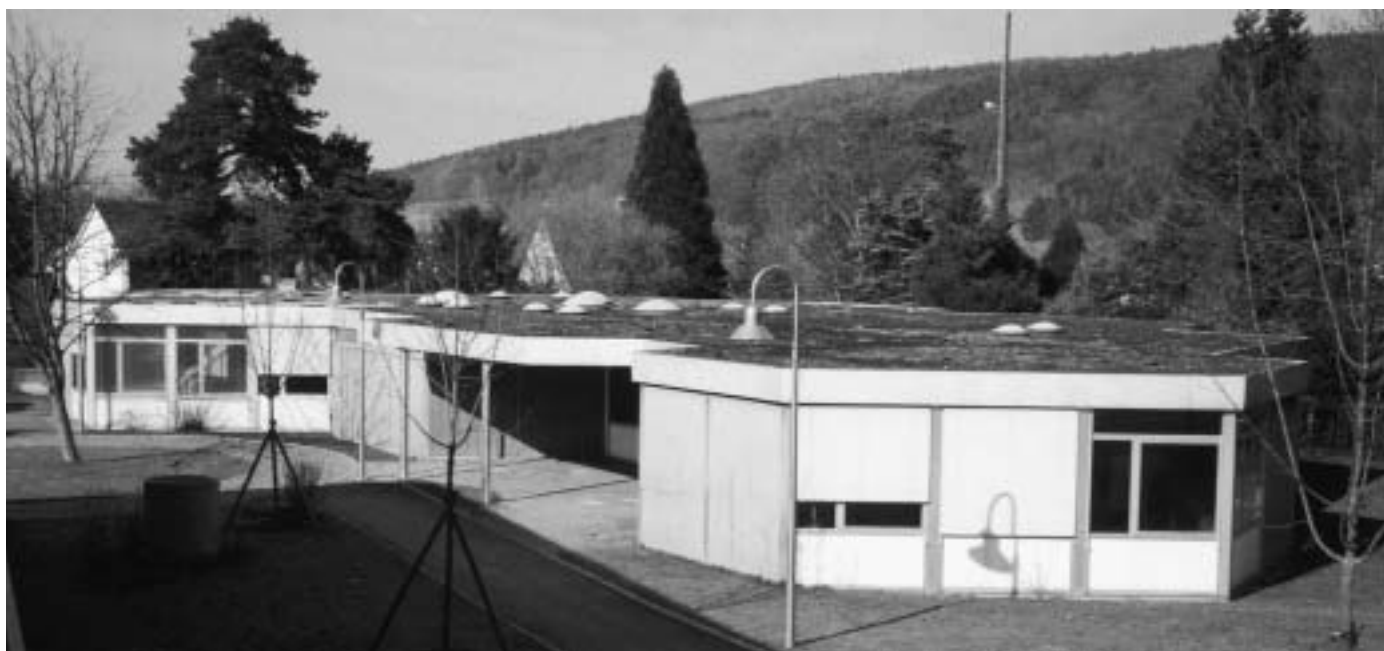
Die ehemalige Schule der Gemeinde Steißlingen vor der Demontage im April 2003.
