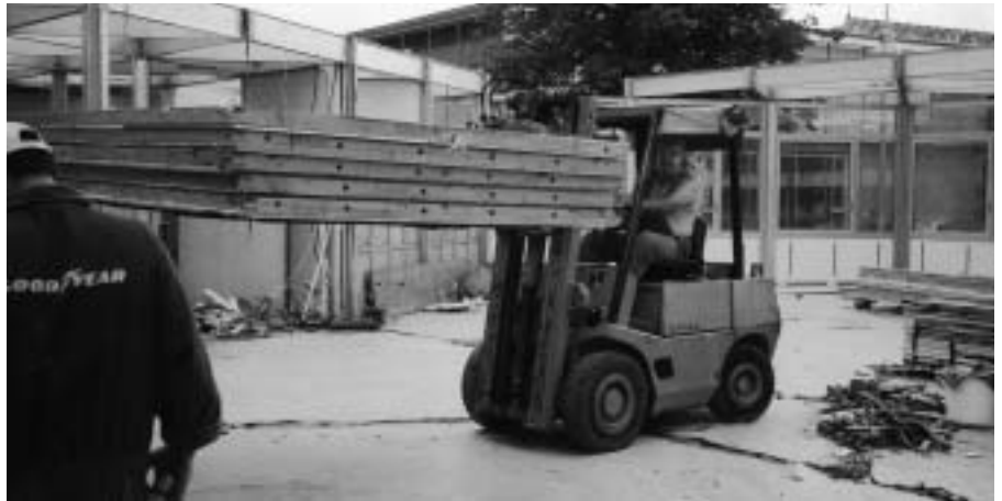
Ohne den starken Gabelstapler aus unserem Zentrallager in Engen wären der Abbau und das Beladen nicht möglich gewesen.
