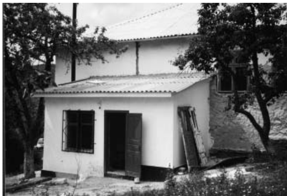
Das von mir monierte fehlende Fenstergitter (Einbruchsicherung) im Heizhäuschen ist nun ebenfalls vorhanden.
