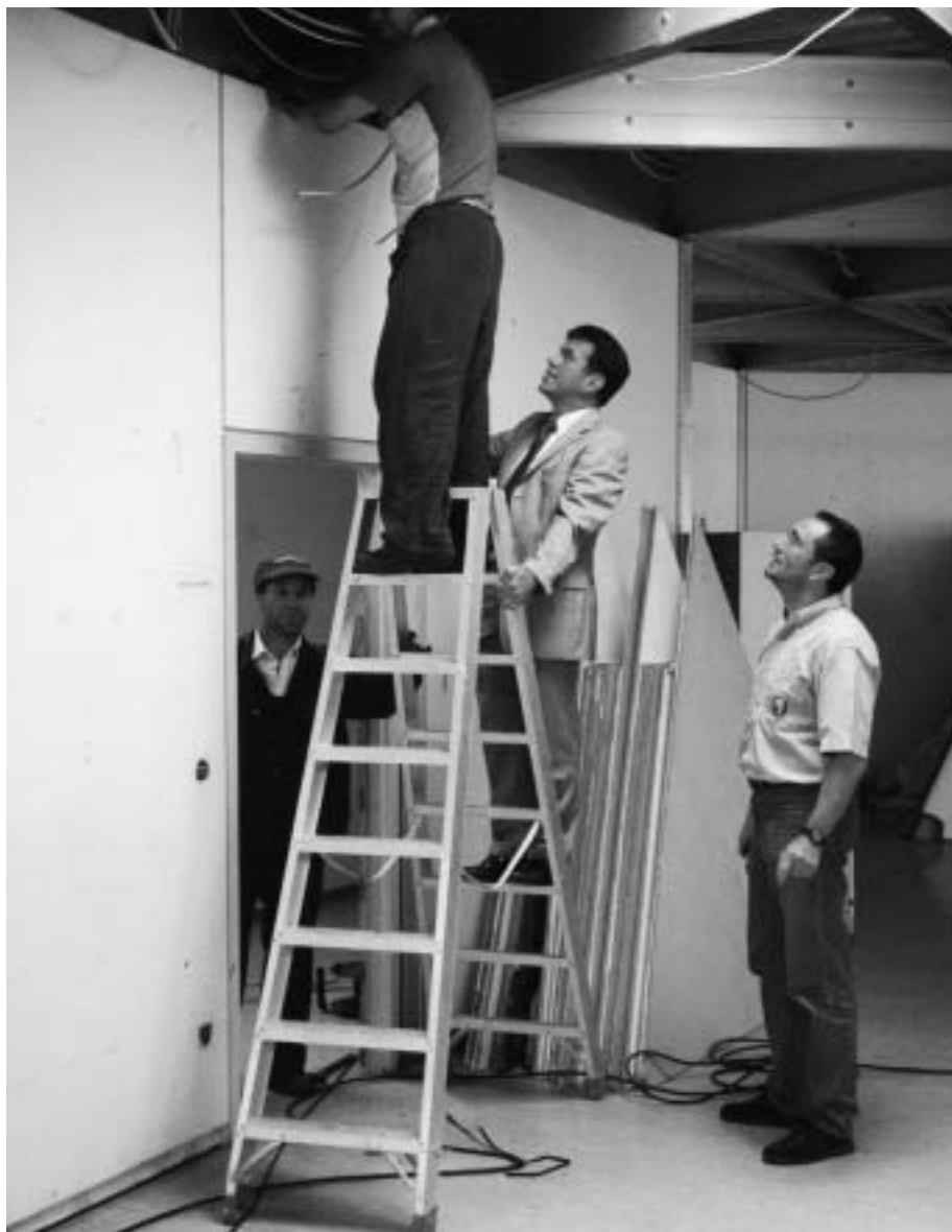
Demontage der Elektroleitungen und Wandplatten.
