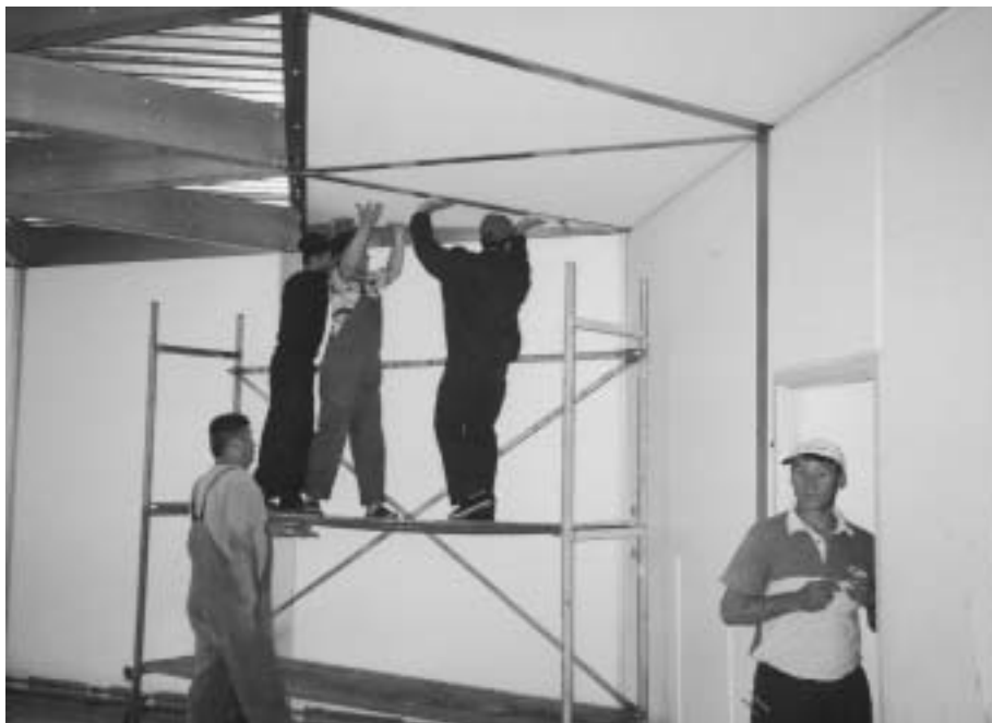
Beginn der Demontage. Hier werden die Deckenplatten demontiert.
