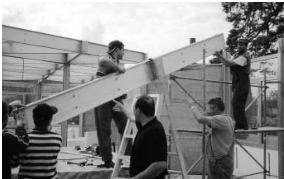
Unter Aufsicht des Bauingenieurs werden die Aluminiumprofile herabgenommen.
