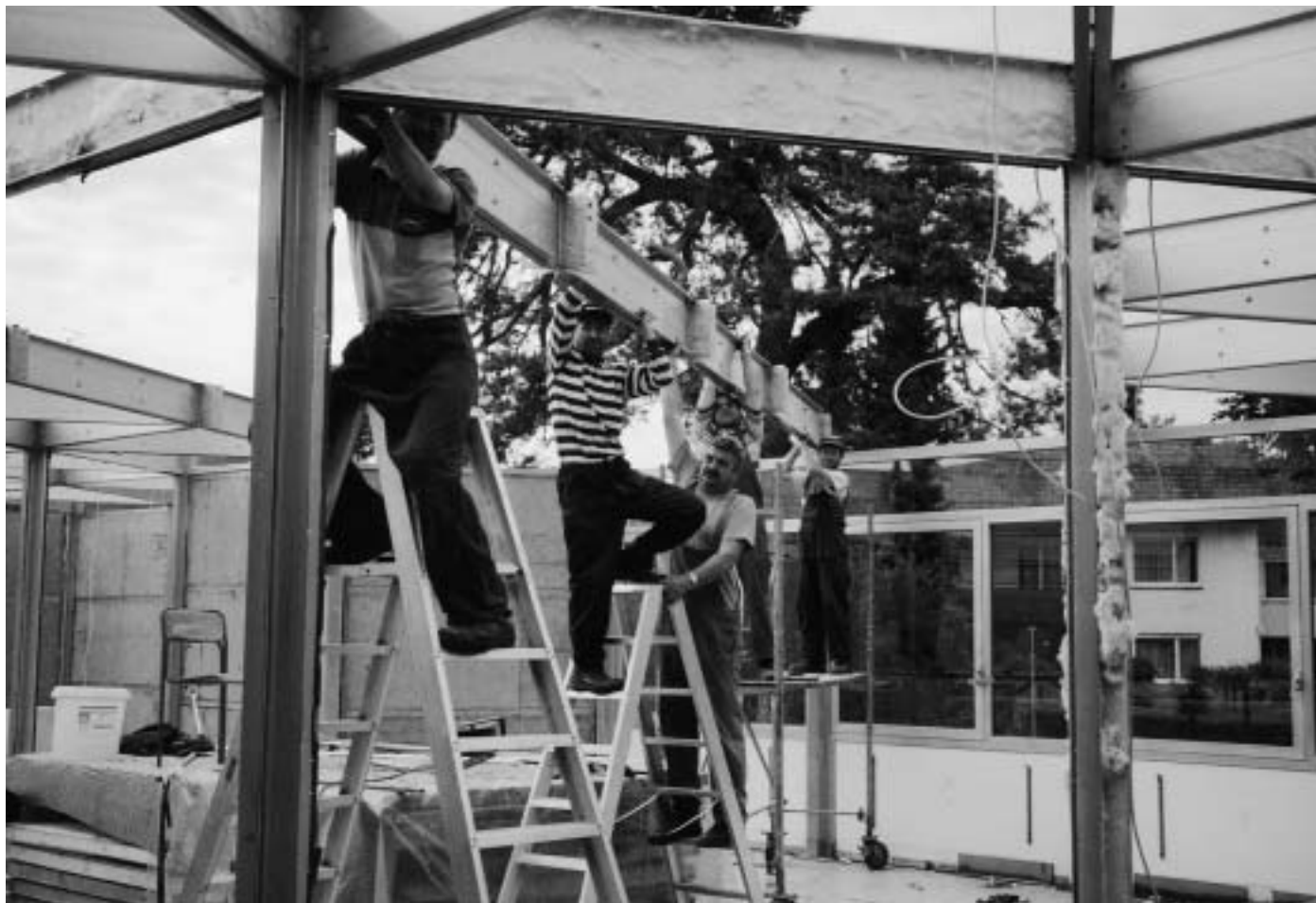
Die tragenden Aluminiumprofile werden abgebaut. Hierbei handelte es sich um den gefährlichsten Teil der Arbeiten.
