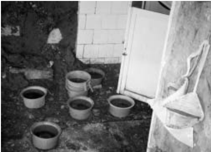
Bisherige Unterkunft von Kindern in der Moldau, mit Tontöpfen wird das Wasser aus dem undichten Dach aufgefangen. Bild: Hartig
