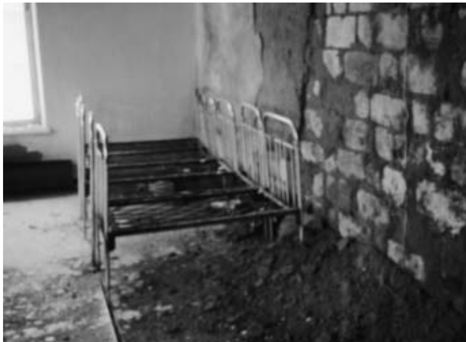
Die völlig durchnässten Räume stellen eine schwere gesundheitliche Gefahr für die Kinder dar. Endlich hat man sich zur Räumung dieser Station entschlossen.
