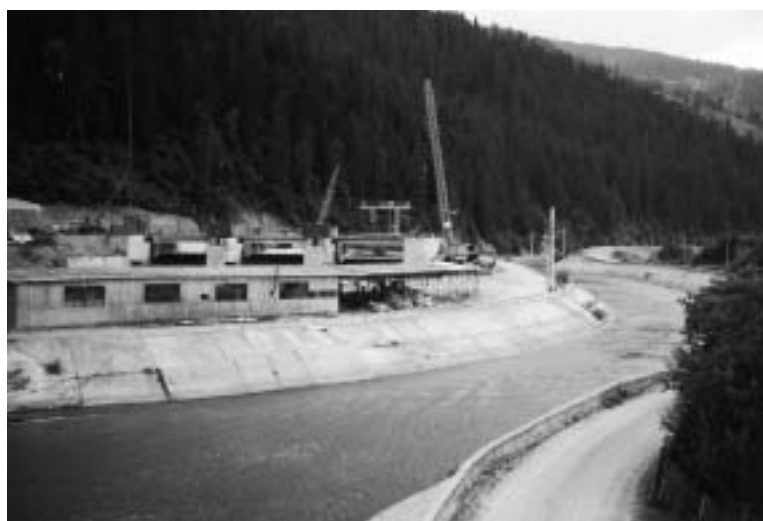
Betonierung und Erhöhung der Flussdämme
