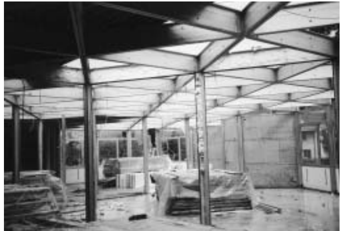
Der geöffnete Schulbau. Innenansicht mit gelagerten Wandplatten.
