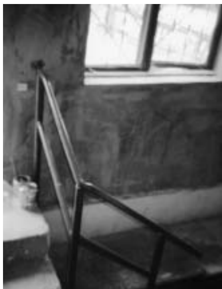
Das von mir als fehlend monierte Treppengeländer im Heizhäuschen ist nun vorhanden.
