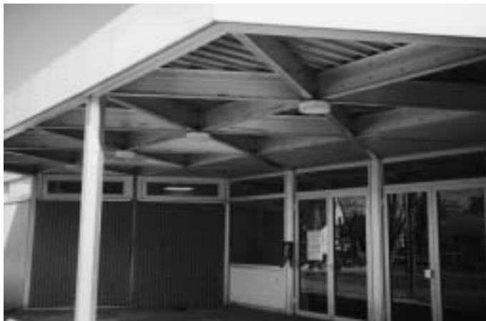
Eingangsbereich der Schule. Die Deckenelemente sind bereits entfernt.
