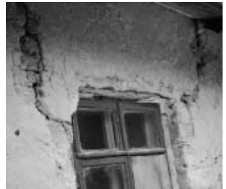
Fenster mit verfaultem Fenstersturz und darüber liegendem brüchigem Mauerwerk
