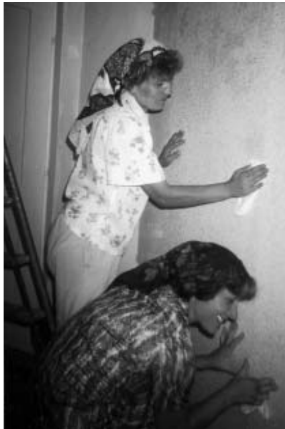
Für die feineren Verputzarbeiten werden in der Regel nur Frauen eingesetzt. Es erstaunt mich immer wieder, mit welcher Handfertigkeit gerade Frauen die Verputzarbeiten vornehmen. Wenn man eine Latte setzt, ist es nicht möglich, einen Geldschein zwischen Wand und Messlatte durchzuschieben.
