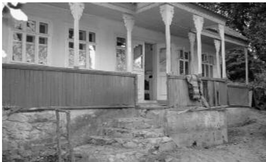
Der völlig desolate Vorbau des Hauses Chiriac muss entfernt werden. Da das Haus am Hang steht und teilweise wegrutscht, müssen Fundamente geschaffen werden.
