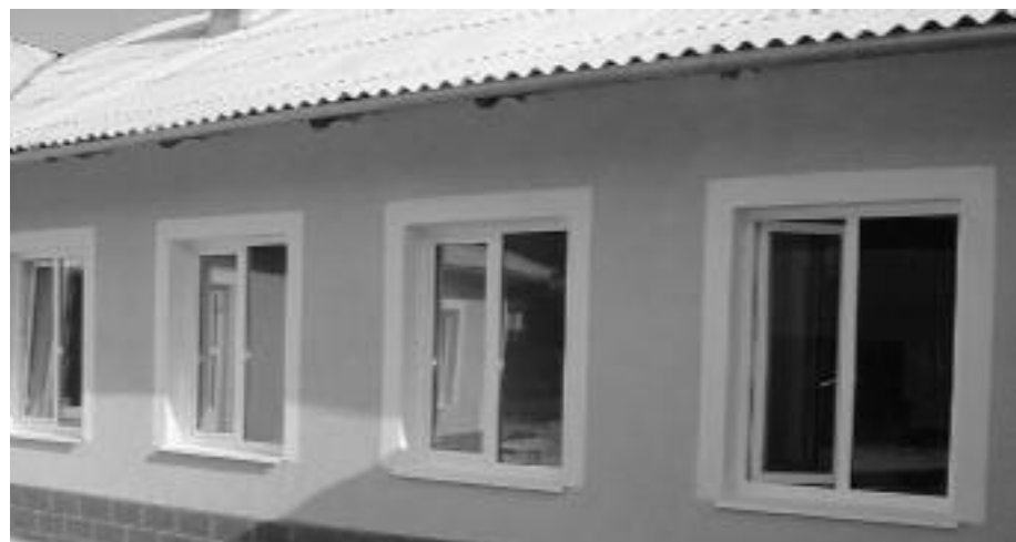
Fensterfront mit den neuen Thermopenfenstern und neuem Außenputz
