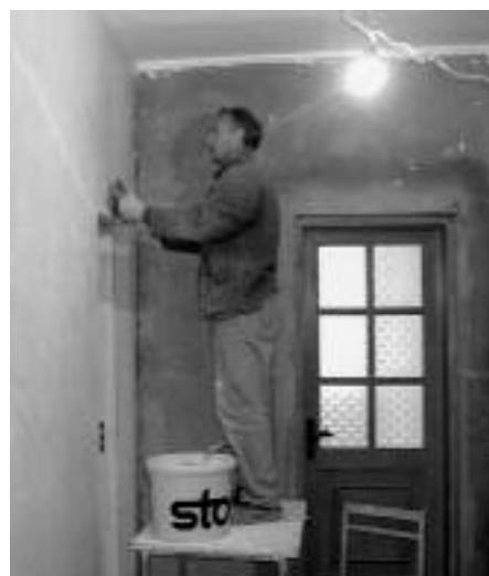
Ein Arbeiter beim Verputzen der Wände in der Zentralklinik in Chisinau.
