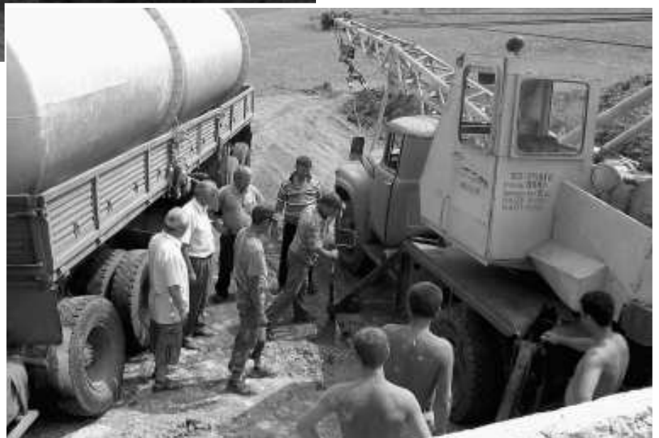
Mit einem Kranwagen werden die Wasserbehälter abgeladen.
