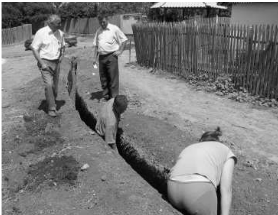
Auch die Bevölkerung half mit, nachdem starker Regen die Leitungsgräben teilweise wieder zugeschwemmt hatte.
