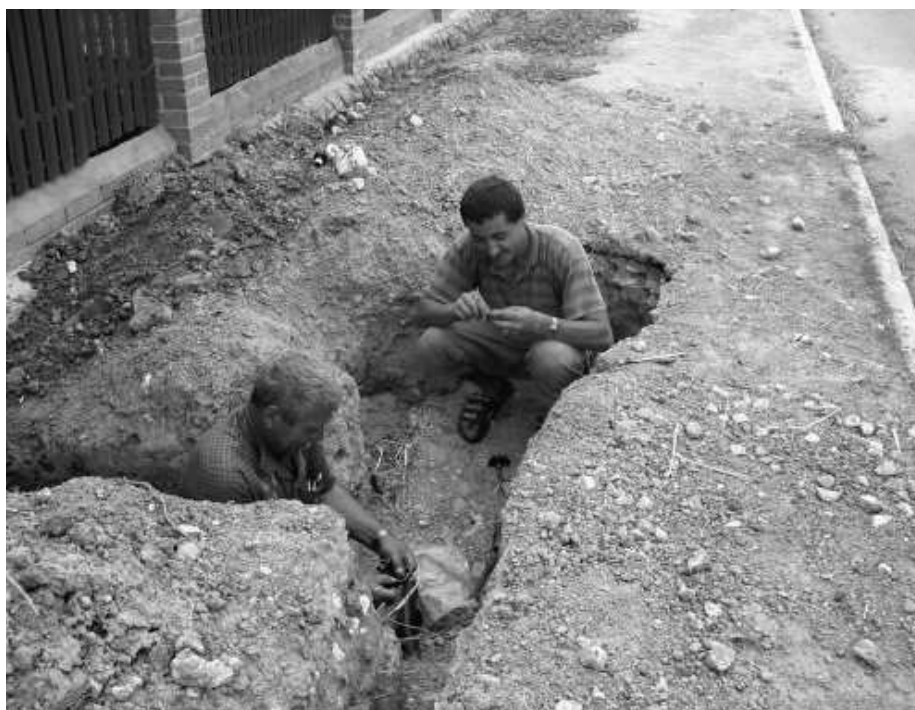
Die Hausanschlüsse werden gelegt
