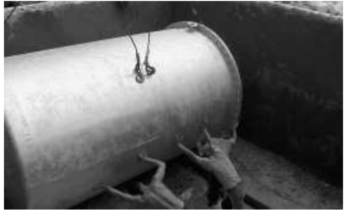
Montage der Wasserbehälter. Man beachte die Proportion Mensch und Material
