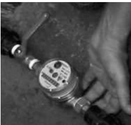
Hauswasseranschluss mit Wasseruhr.
