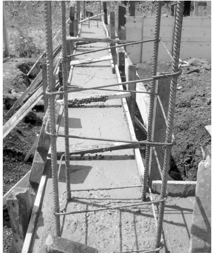
...nach Betonverfüllung.
