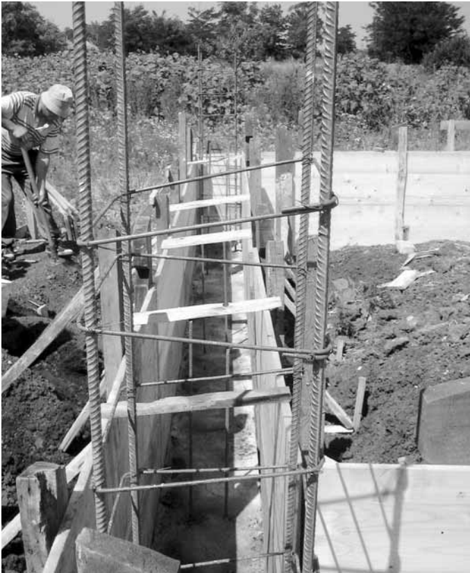
■ Fertig gestellte Betonverschalung vor Betonverfüllung
