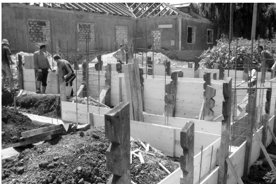
■ Die angelieferten Schaltafeln finden Verwendung für das Sichtbetonmauerwerk..
