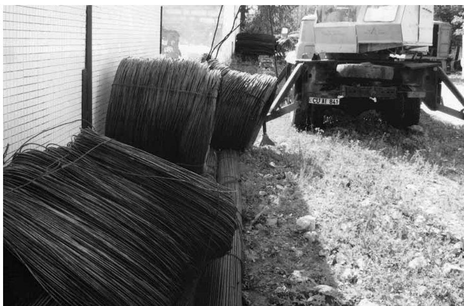
Baustahl wird angeliefert, der für die Betonarmierung verwendet werden soll.
