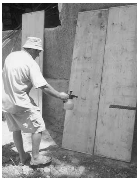
■ Die Schaltafeln werden vor Gebrauch mit Schalöl eingesprüht
