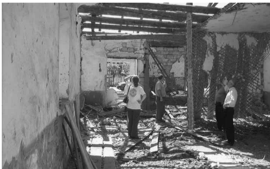
Entkernung im Altbauteil des Schulprojektes. Das Dach wird entfernt
