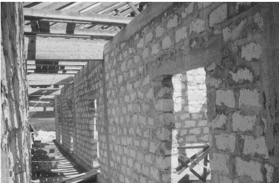
■ Rohausbau des Altbauteiles mit Klassenzimmern
