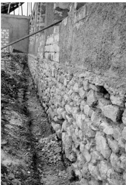
■ Die Drainagearbeiten am Altbauteil sind noch unerledigt
