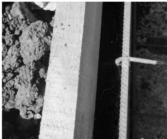
■ Richtig eingelegte Baustahlarmierung! Abstand ist vorhanden.
