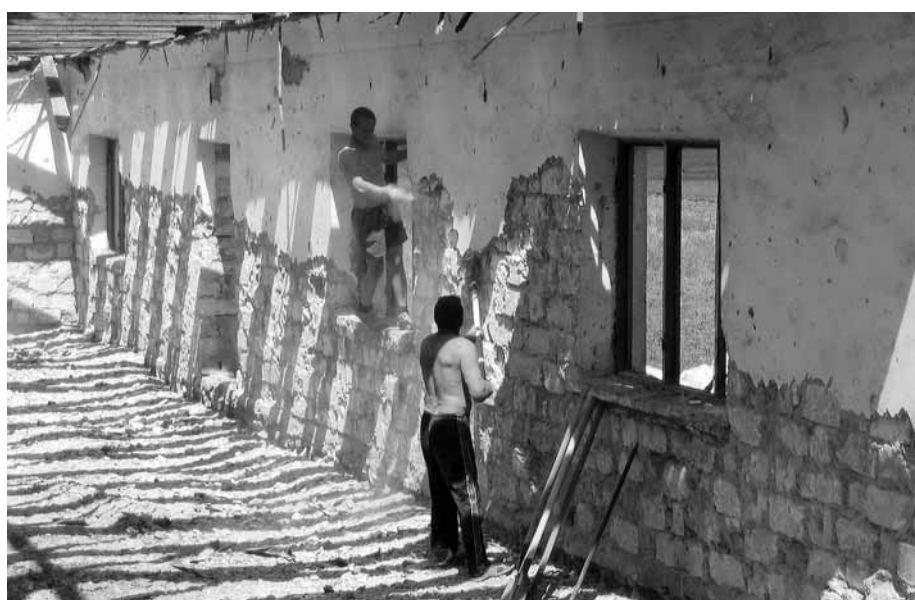
Abschlagen des Altbauputzes im Altbauteil des Schulprojektes. Bei der Aufnahme dieses Bildes gab es den Vorwurf meinerseits, der mangelnden Sicherheit für die Bauleute an den verantwortlichen Bauingenieur Bilder: Hartig
