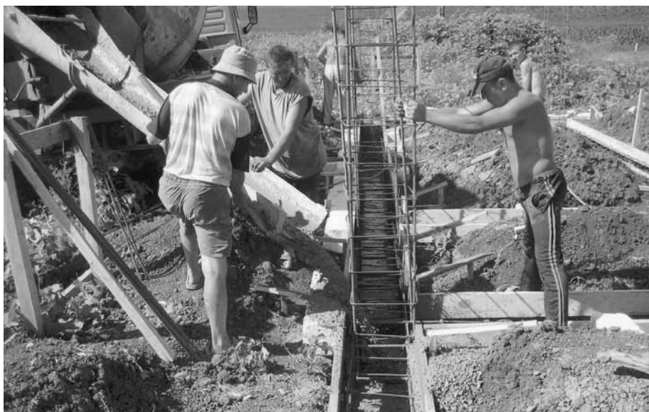
■ Das Grundfundament wird mit Beton gefüllt.
