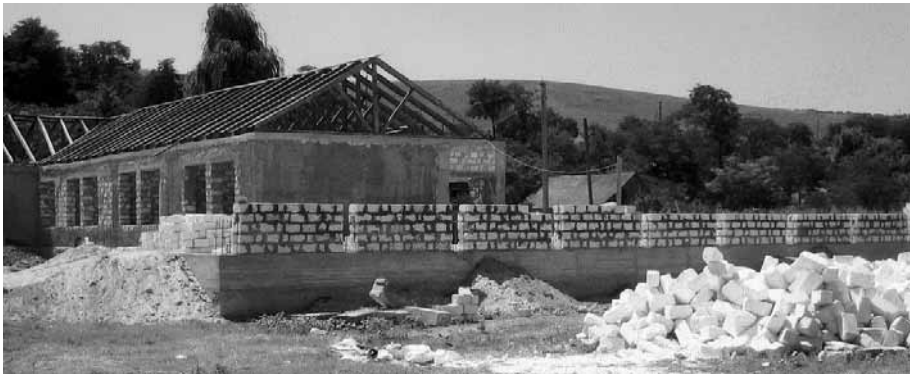
■ Außenansicht des Schulprojektes. Man erkennt im Vordergrund die hüfthohe Mauer des Neubauteils auf dem Fundament
