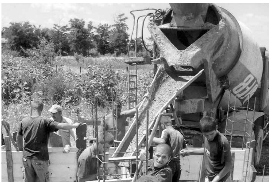
■ Erstellung des Sichtbetonmauerwerks
