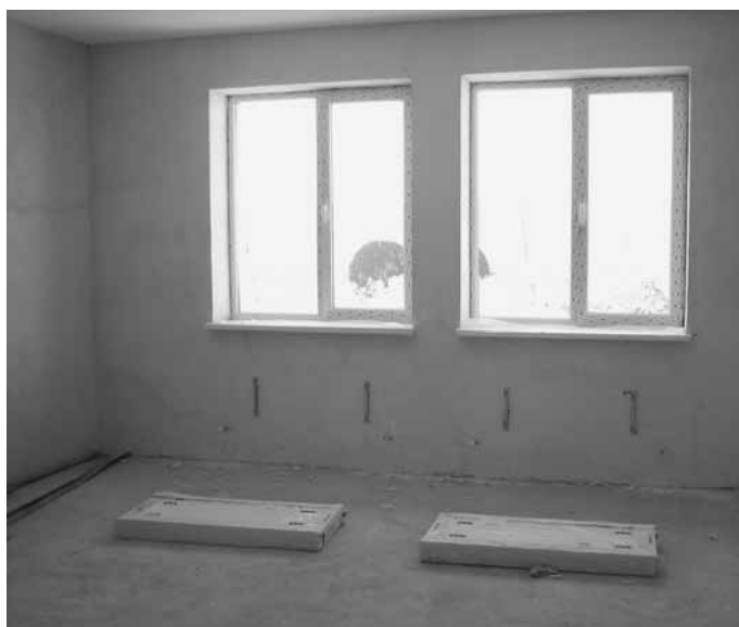
■ Klassenraum noch unverputzt mit Vormontage der Heizkörper
