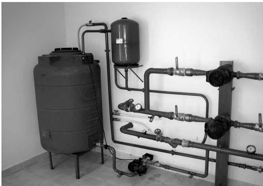
■ Der Heizungsraum mit seinem Vorrats- und Dehngefäß, Pumpen und Ventilen
