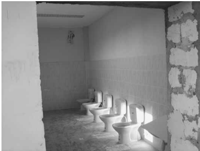
■ Mädchentoilettenraum im Rohbauzustand
