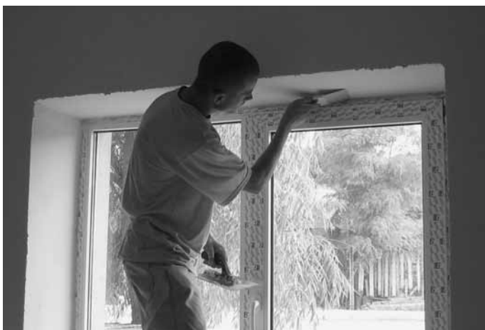
■ Mit besonderer Sorgfalt werden auch die Fensterlaibungen verputzt
