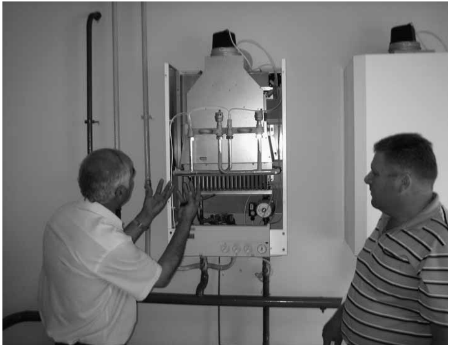
■ Bürgermeister Ion Luchian, links, lässt sich die Funktionsweise vom Heizungsbauer erklären
