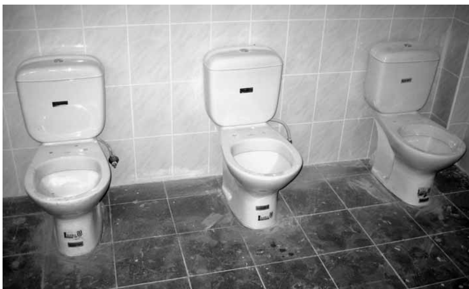
■ Rohmontage der Duravit Toiletten. Toilettendeckel und Kabinen fehlen noch.
