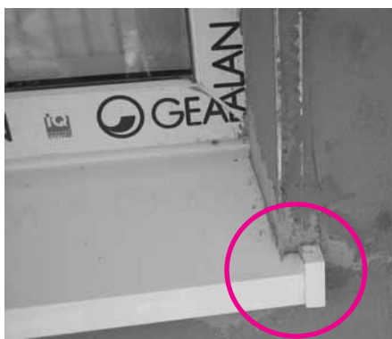
■ Falsch montierte Fensterbretter. Es mussten alle ausgebaut und neu montiert werden.
