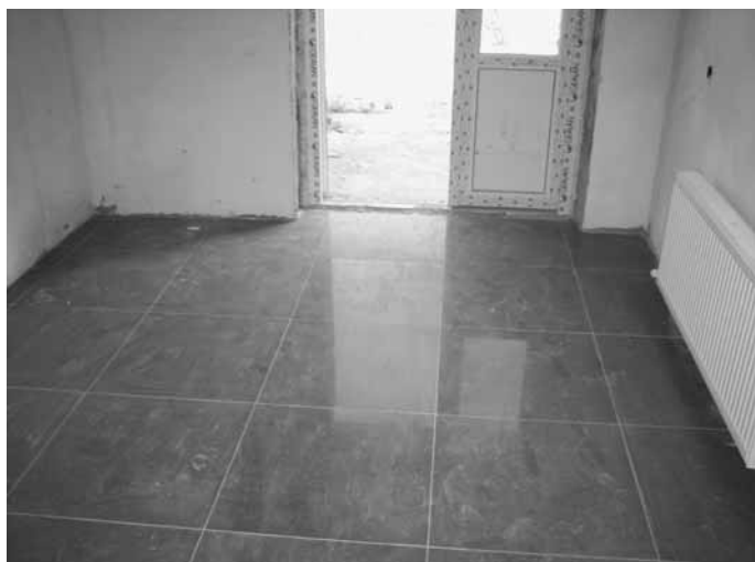
■ Der halbfertige Eingangsbereich der Schule. Man erkennt, dass die Heizkörper montiert sind. Der Fußboden ist besonders schön geworden.
