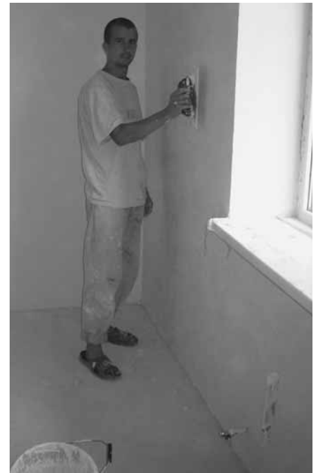
■ Hier wird der Innenputz aufgetragen
