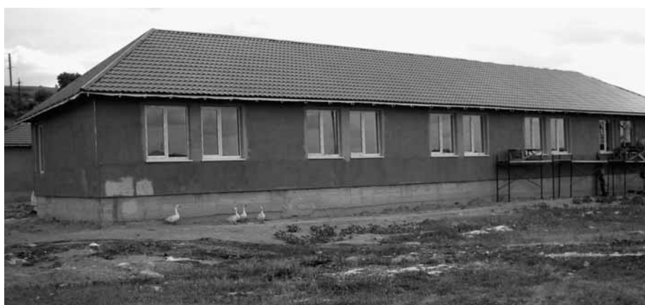
■ Bild oben: Der Rohverputz außen ist fertig. Dachrinnen müssen noch montiert werden. Bild unten: Neubauteil der Schule mit hochgezogenem Fundament. Wegen der „bestialischen“ Außentemperatur von 48° Celsius kann der Fertigputz derzeit nicht aufgetragen werden.
