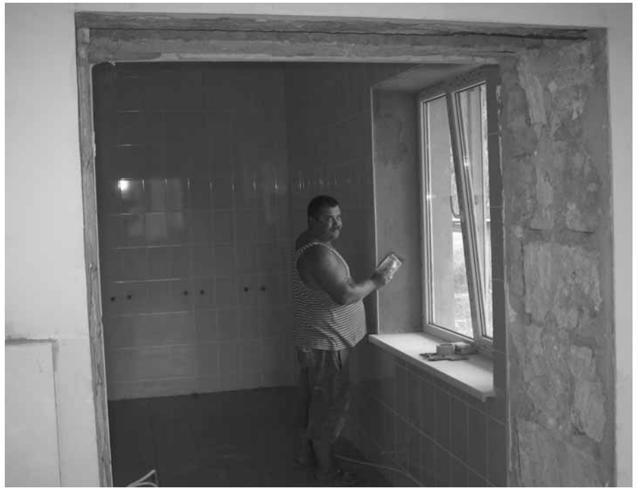
■ Grundputzarbeiten im Küchenraum der Schule in Milestii-Noi
