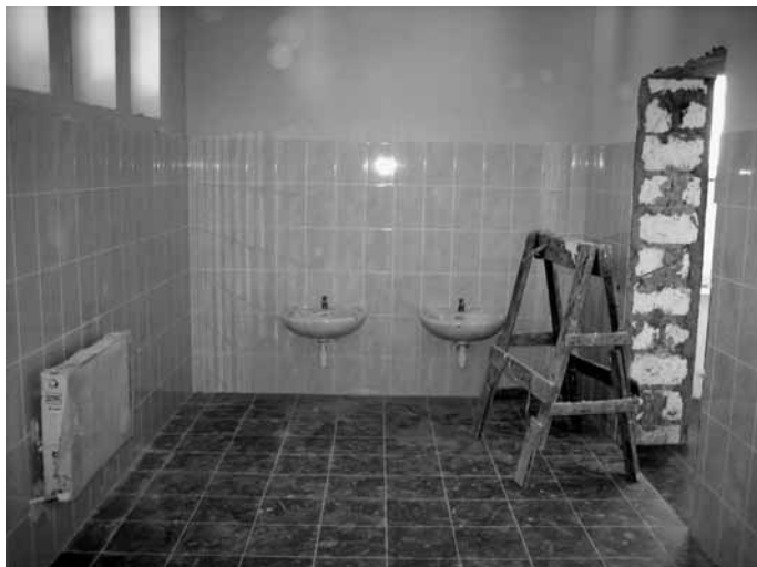
■ Der Toilettenraum der Jungen. Noch müssen die Türen eingebaut werden. Die Waschbecken haben eine „kindgerechte“ Höhe
