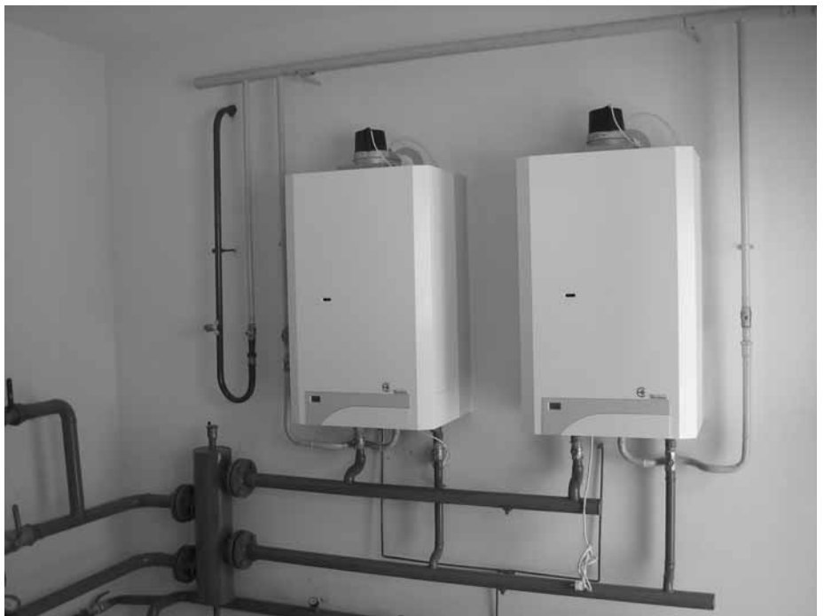
■ Die fertig montierte Gasheizungsanlage
